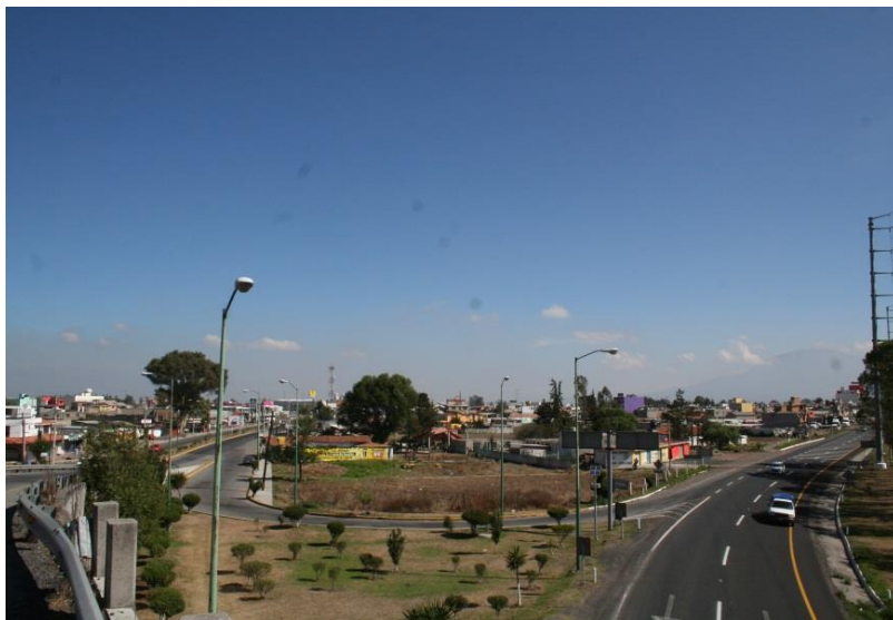
Zona más poblada de Ixtlahuaca. Puente previo a la Terminal de Autobuses. Foto: Laura Hernández Guadarrama. Junio, 2013.
