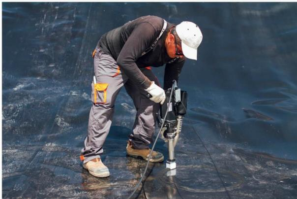
*Nota. Tomado de Soldar geomembrana por extrusión [Fotografía], Aristegui Maquinaria, s.f., Aristegui (<https://www.aristegui.info/soldar-geomembrana-por-extrusion/>).*
