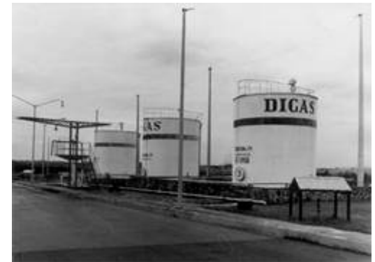
Imagen 2: Estación de combustible DIGAS.
