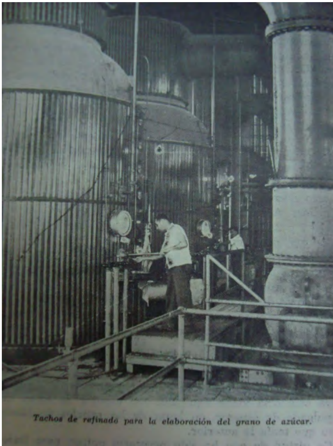
Ingenio del Mante, Cooperativa de Ejidatarios y Obreros del Ingenio del Mante, S.C.L., México, s.n., 1951.
