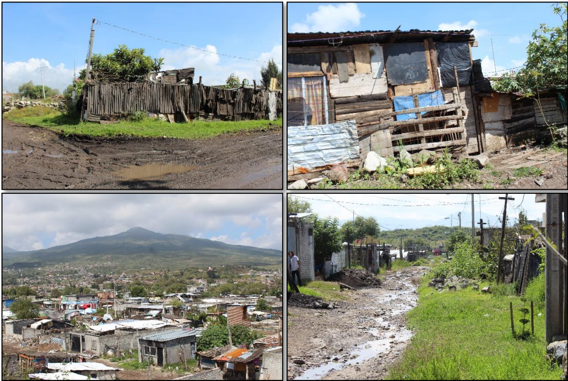
Figura 2. Imágenes ilustrativas de las condiciones de vivienda e infraestructura vial de la Colonia Presa los Reyes.
