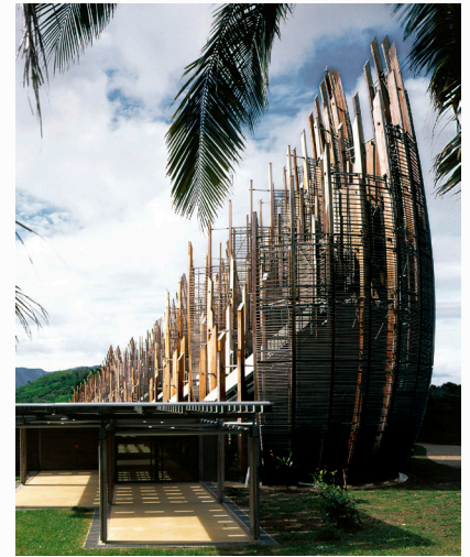
Imagen del Centro Cultural Jean Marie Tjibaou en Nouméa de Renzo Piano, arquitecto reconocido por sus diseños sustentables, imagen tomada de: Schlup, H. (2023). Centro Cultural Jean Marie Tjibaou, Nouméa [Fotografía]. Arquitectura Viva. Madrid. https://arquitecturaviva.com/obras/centro-cultural-jean-marie-tjibaou-noumea
