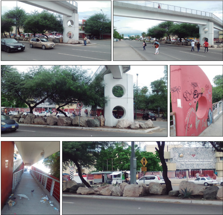
Figura 27. Estado actual de la infraestructura peatonal y vial del sitio de intervención de la ASV. Fuente IMTES, 2022.
