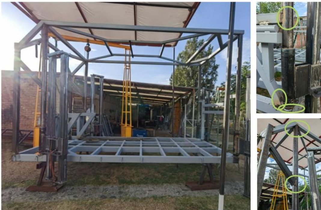
Figura 36. Fotografías tomadas a la estructura principal fabricada, se señalan las uniones donde se realizaron ajustes.
