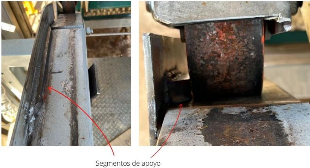
Figura 38. Detalle de Segmentos de apoyo agregados a rampa de guardado.
