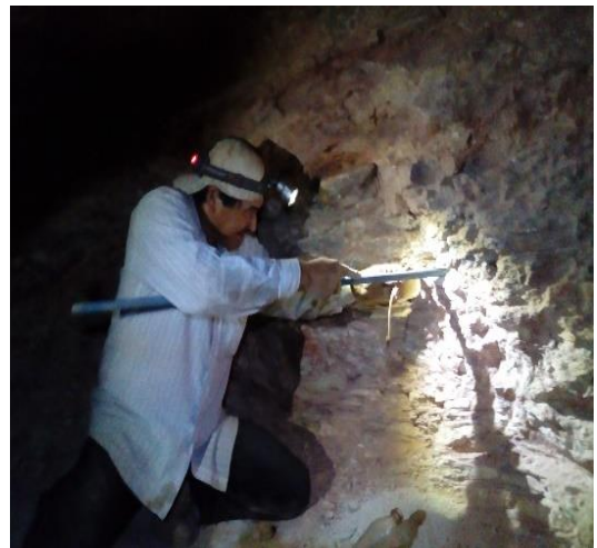
Figura 26. Preparación de barreno para voladura en la MAM. Foto por María Isidra Sánchez Monroy.
