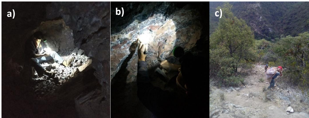
Figura 27. a) Proceso de rezaga, b) proceso de desprender el mineral que queda flojo con la voladura y c) transporte del mineral, de la bocamina a una carretera. Foto por María Isidra Sánchez Monroy.
