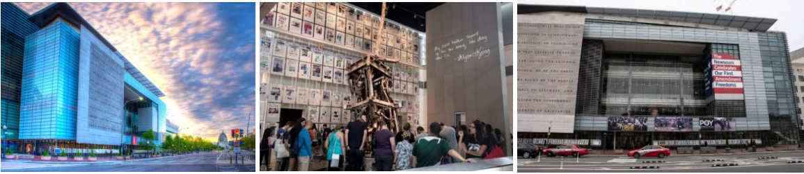
Ilustración 30. Interior y exterior de Newseum. Imagen obtenida en https://raai.com/project/the-newseum/
