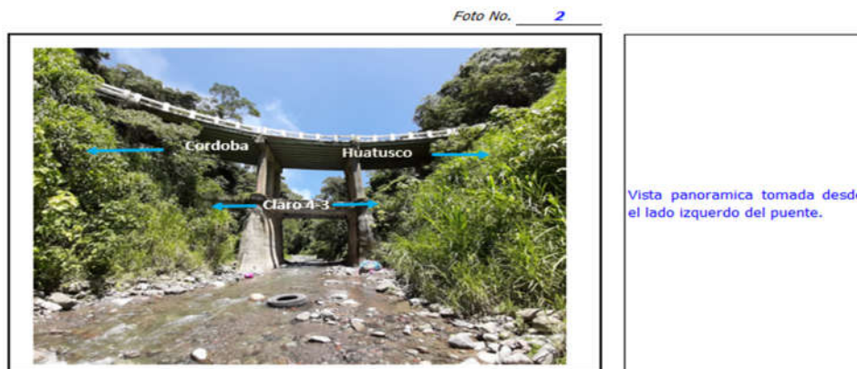
Figura 3.3 Ejemplo de imagen con descripción de una estructura previa (Reporte Fotográfico)
