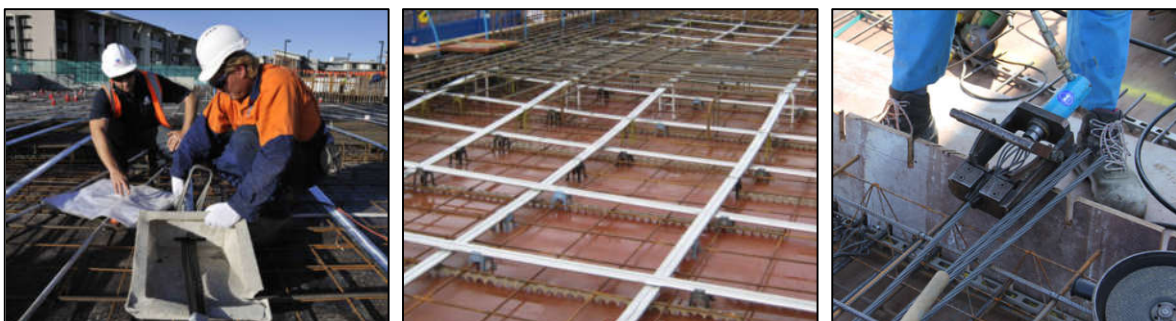
Figura 2.24 Habilitado de acero de presfuerzo y dispositivos de anclaje en losa postensada
