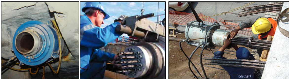
Figura 2.23 Proceso de tensado del acero de presfuerzo en traveses postensados
