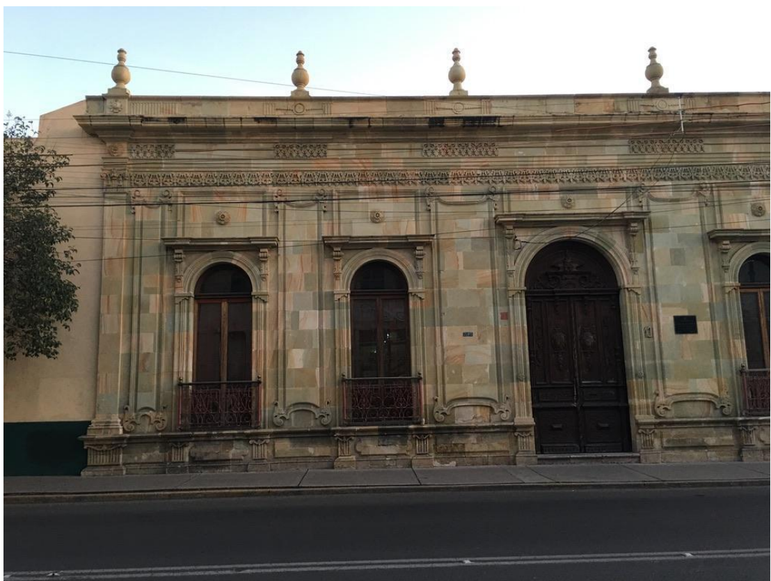
Fachada principal del edificio. Fotografías tomadas a ambos extremos (la calle es demasiado angosta y no se puede visualizar toda la fachada en una misma toma).
