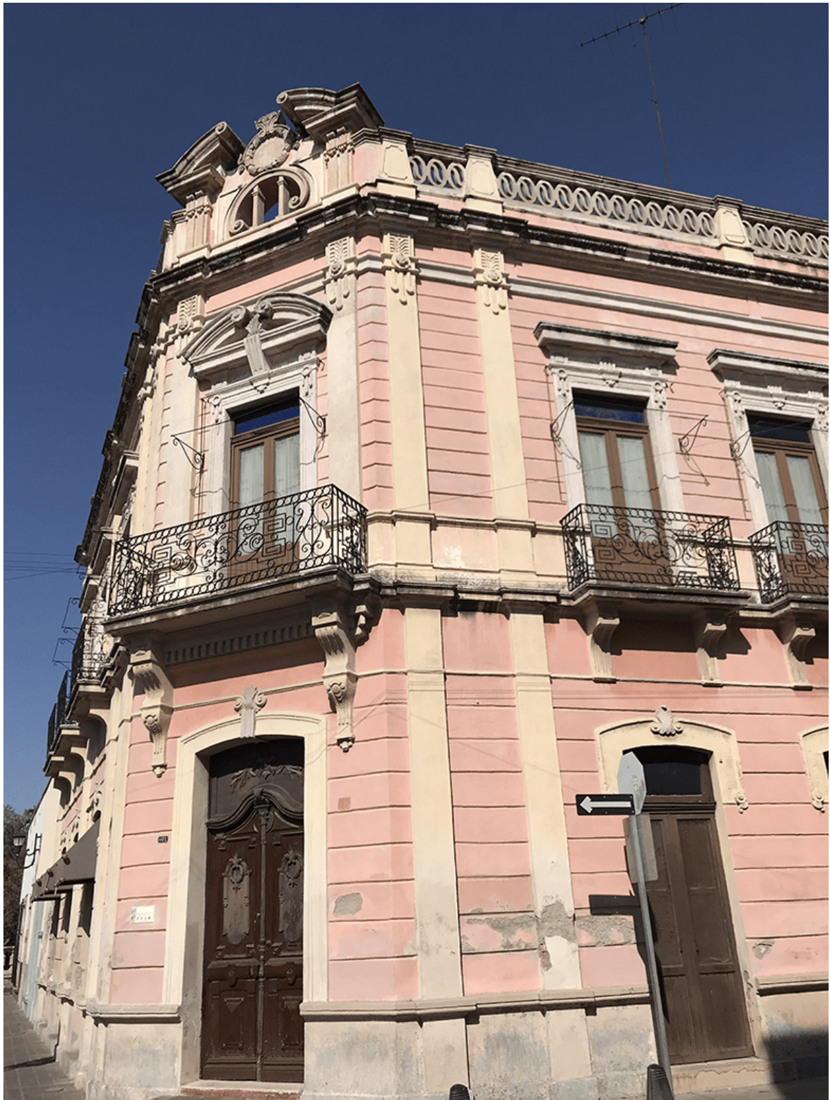
Detalle de la entrada principal.
