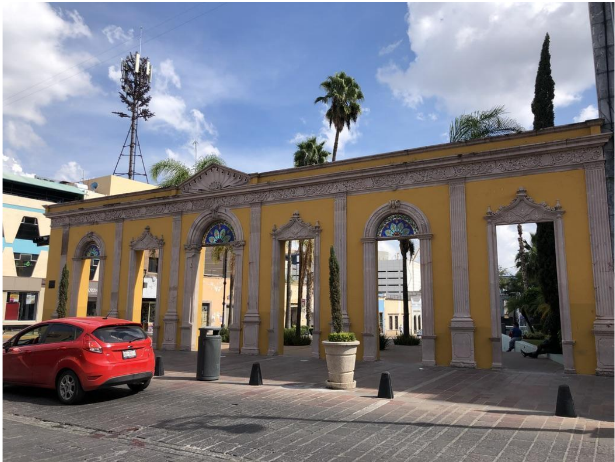
Fachada principal en la actualidad.
