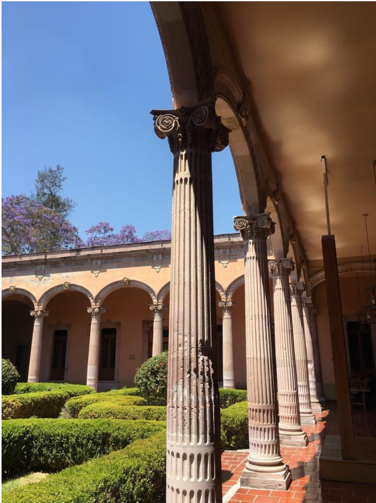
Detalle de columnas del segundo patio.
