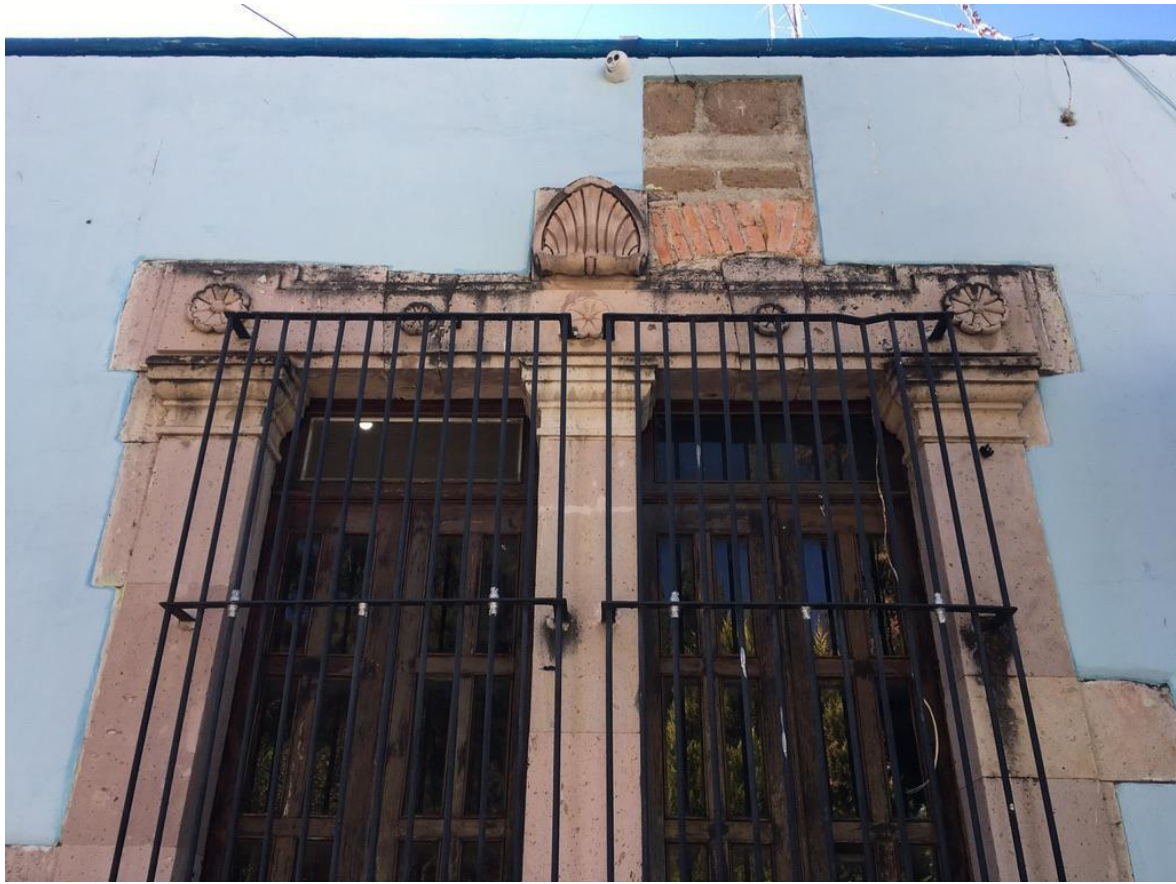
Ventanas en fachada principal.
