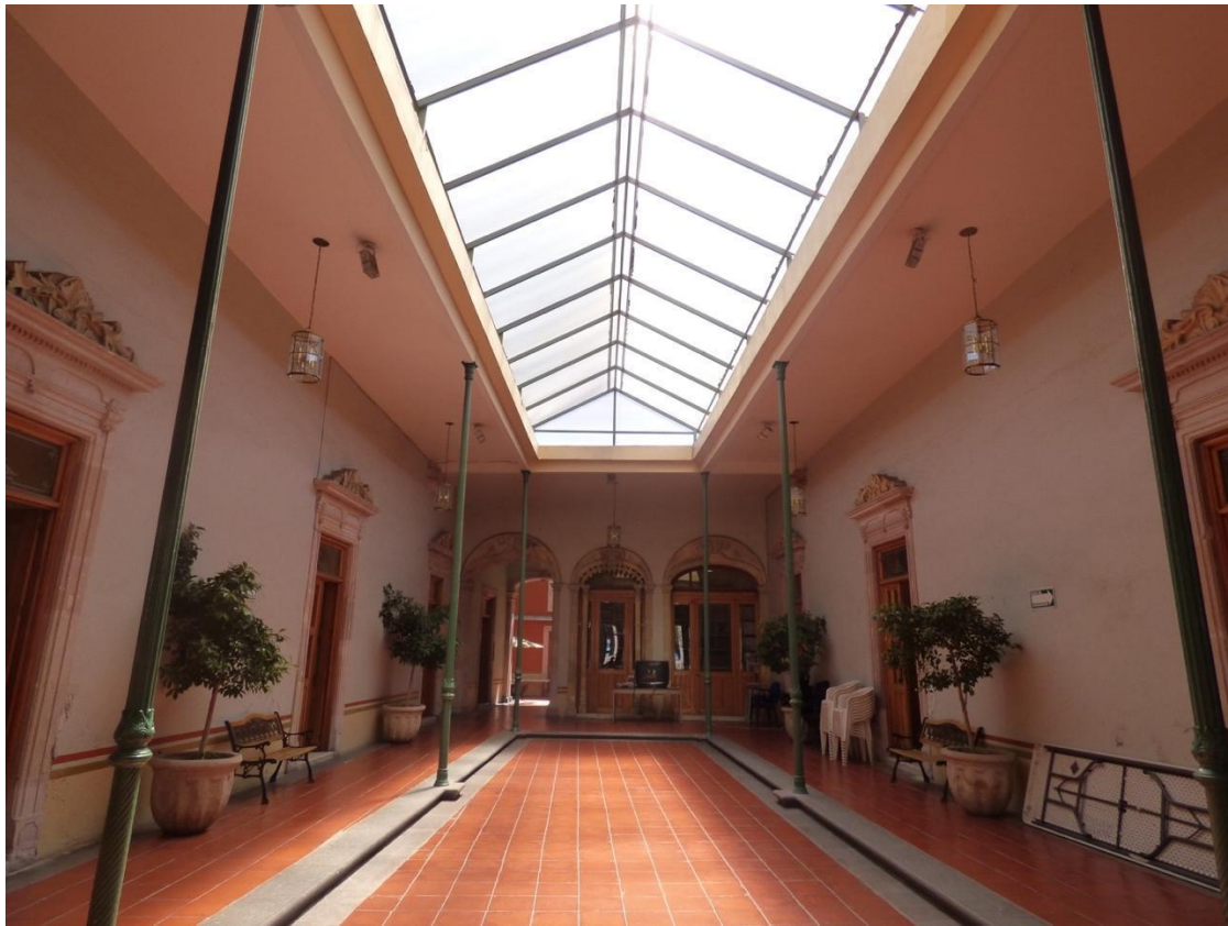
Patio central, donde resaltan las columnas metálicas y la cubierta de cristal.
