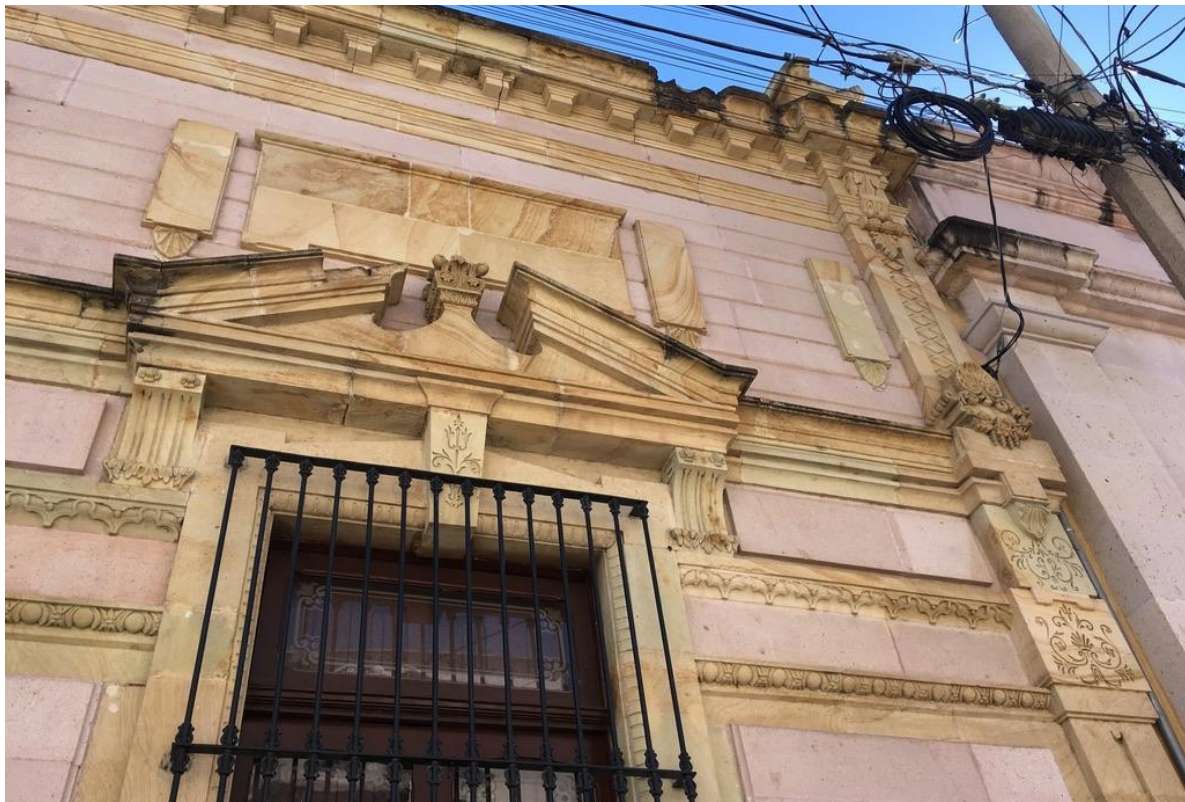
Detalle superior del vano.
