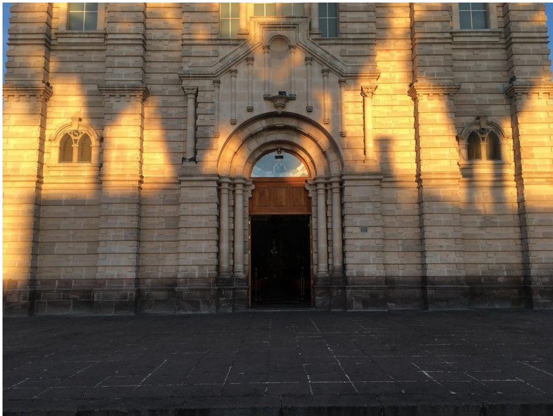
Parte inferior de la fachada principal del templo.
