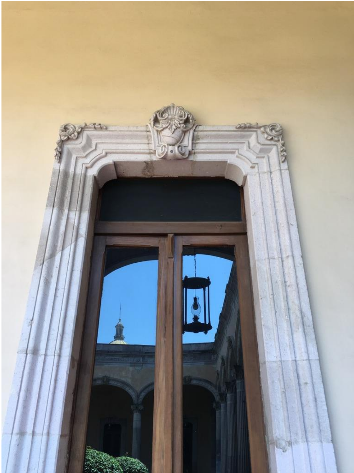
Detalle de ventana en el segundo patio.
