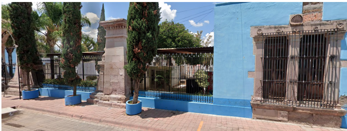
Segmento de fachada principal.
