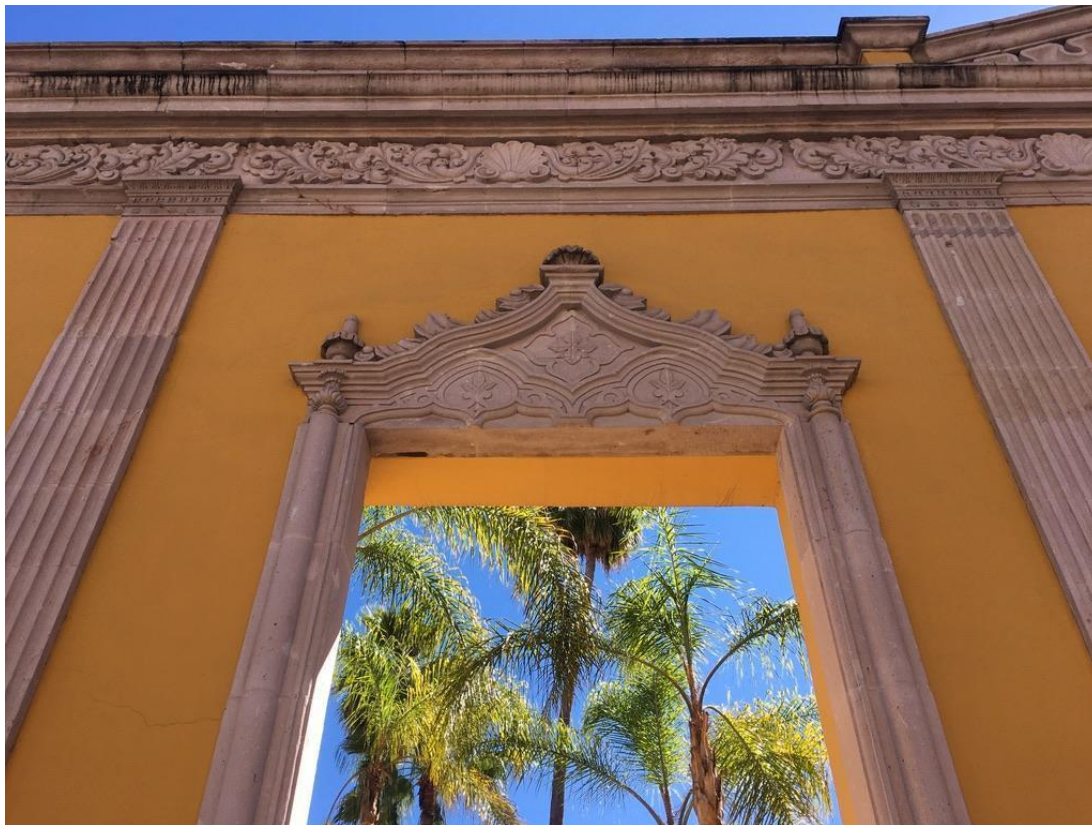
Detalle del arco secundario.
