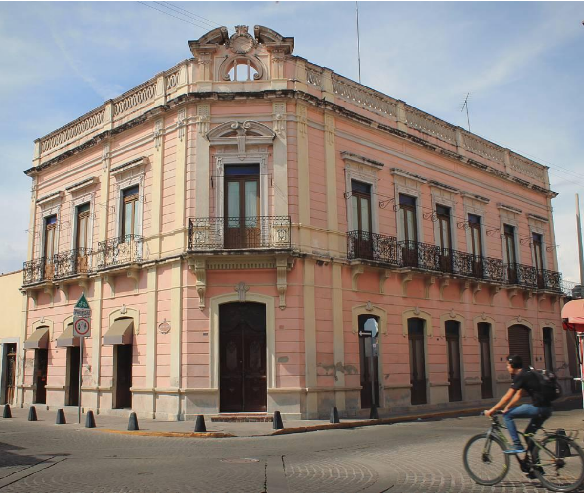
Fachada principal en esquina ochavada.
