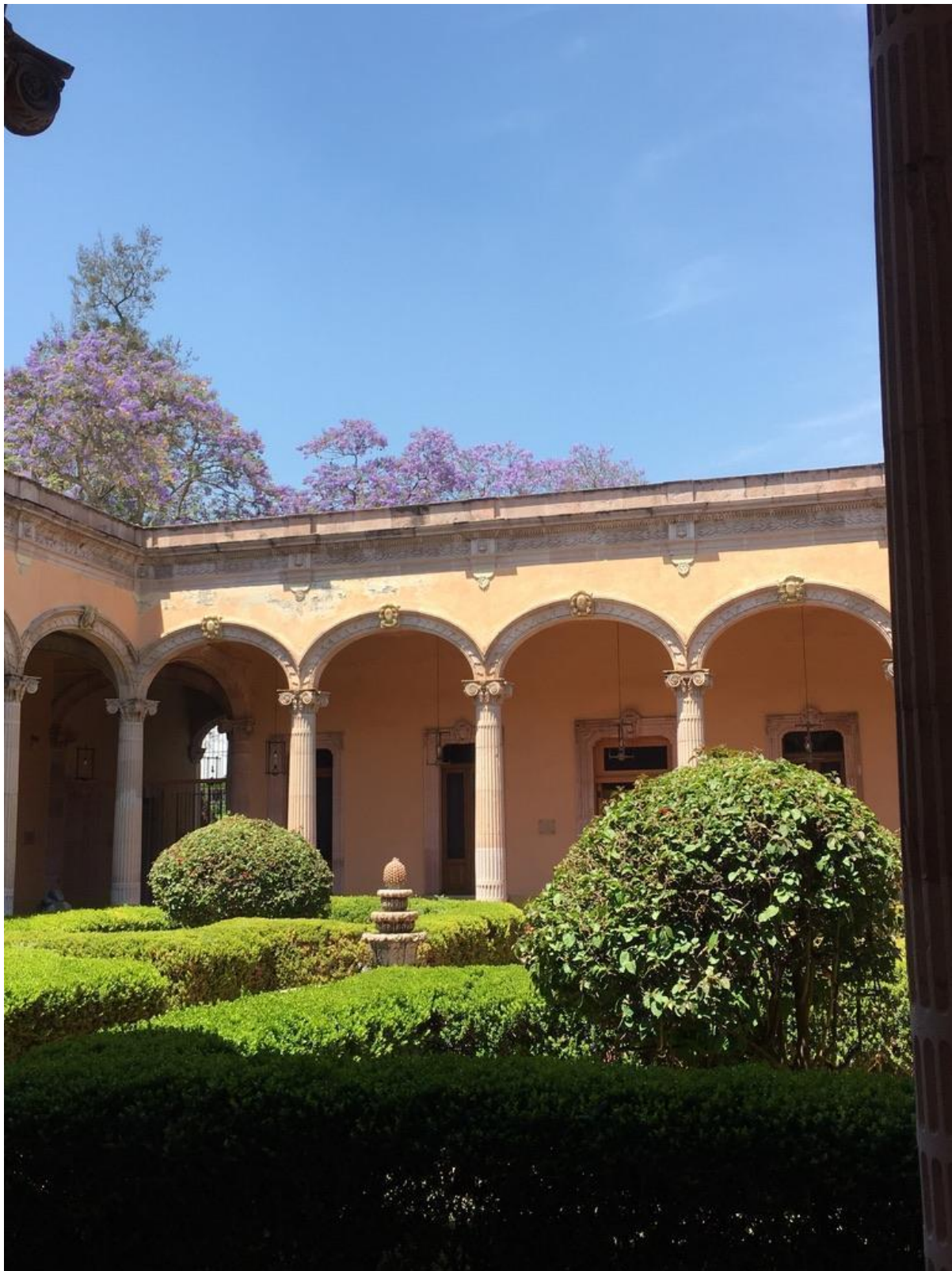
Detalle del exterior de la arcada en el segundo patio.
