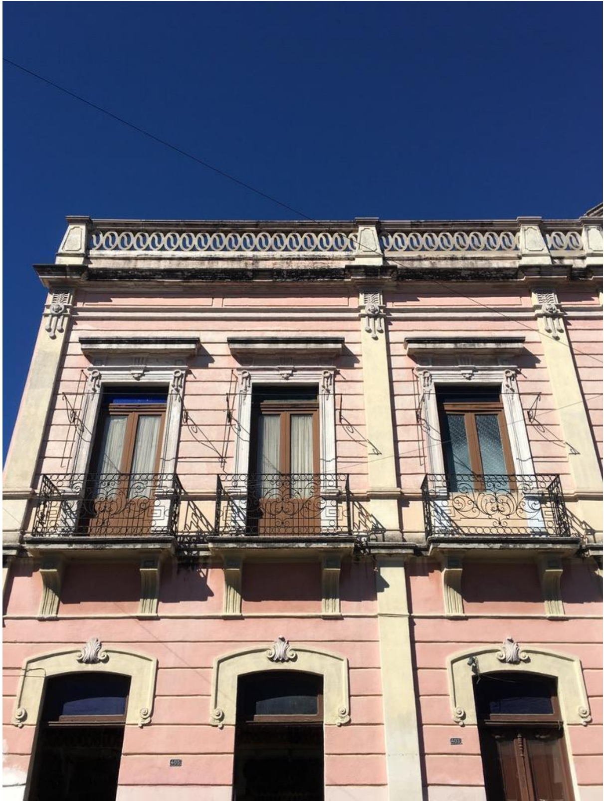
Detalle de ventanas en fachada sur.
