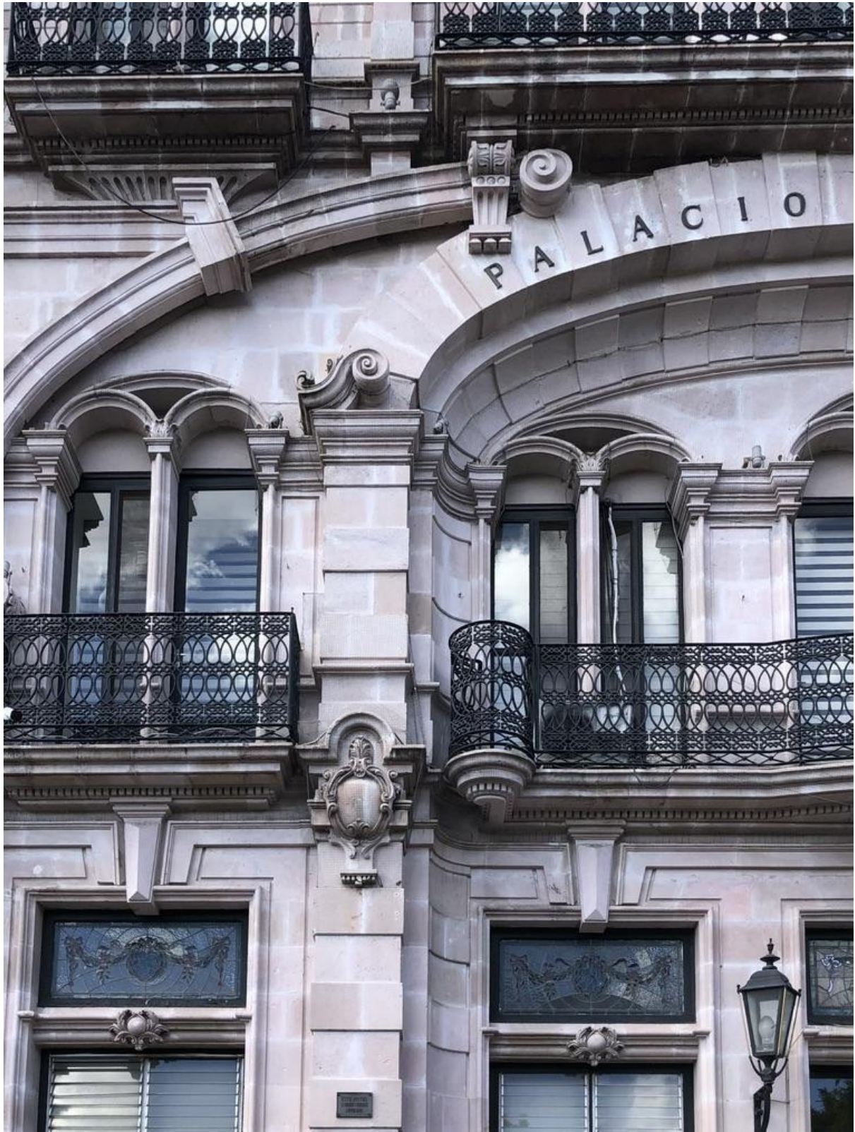
Detalle de fachada.
