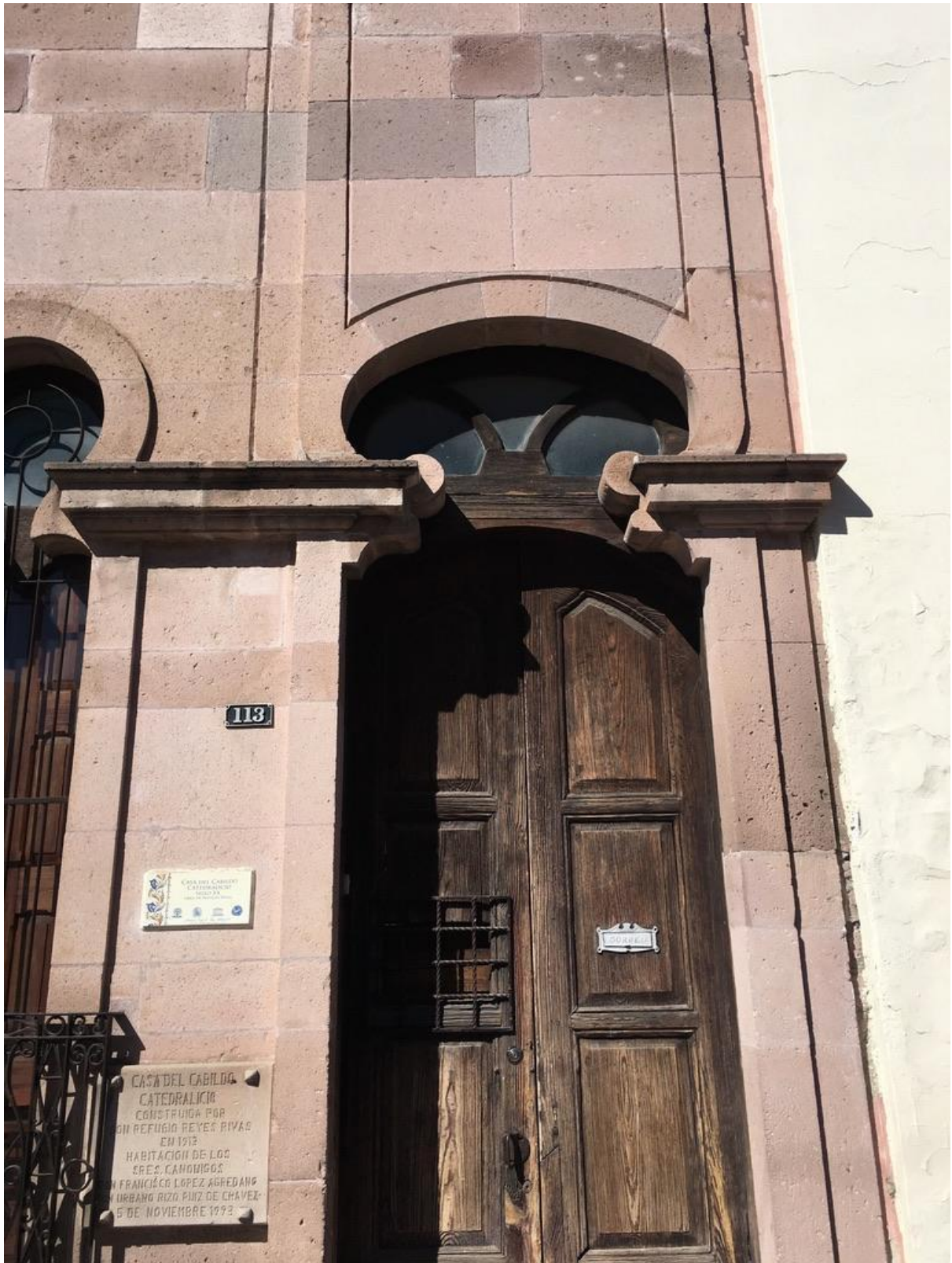
Detalle de la puerta de acceso en fachada.
