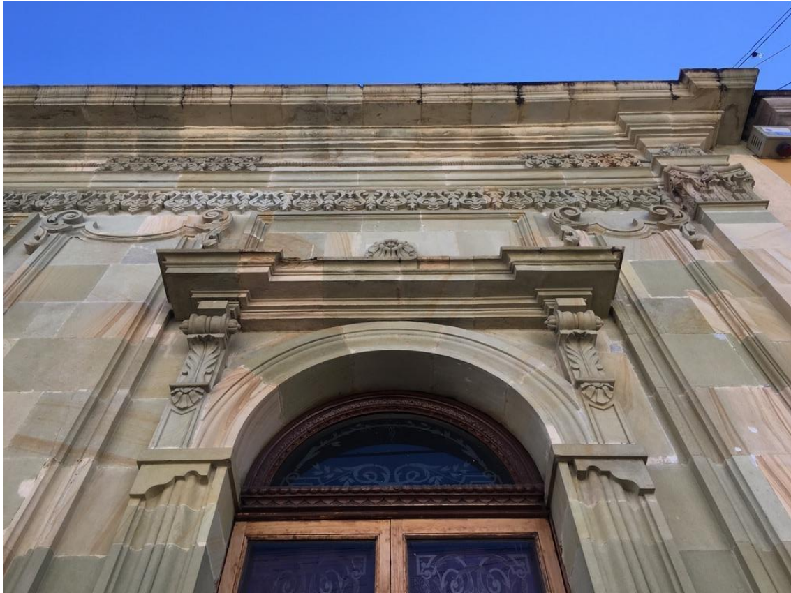
Detalle del arco en fachada.
