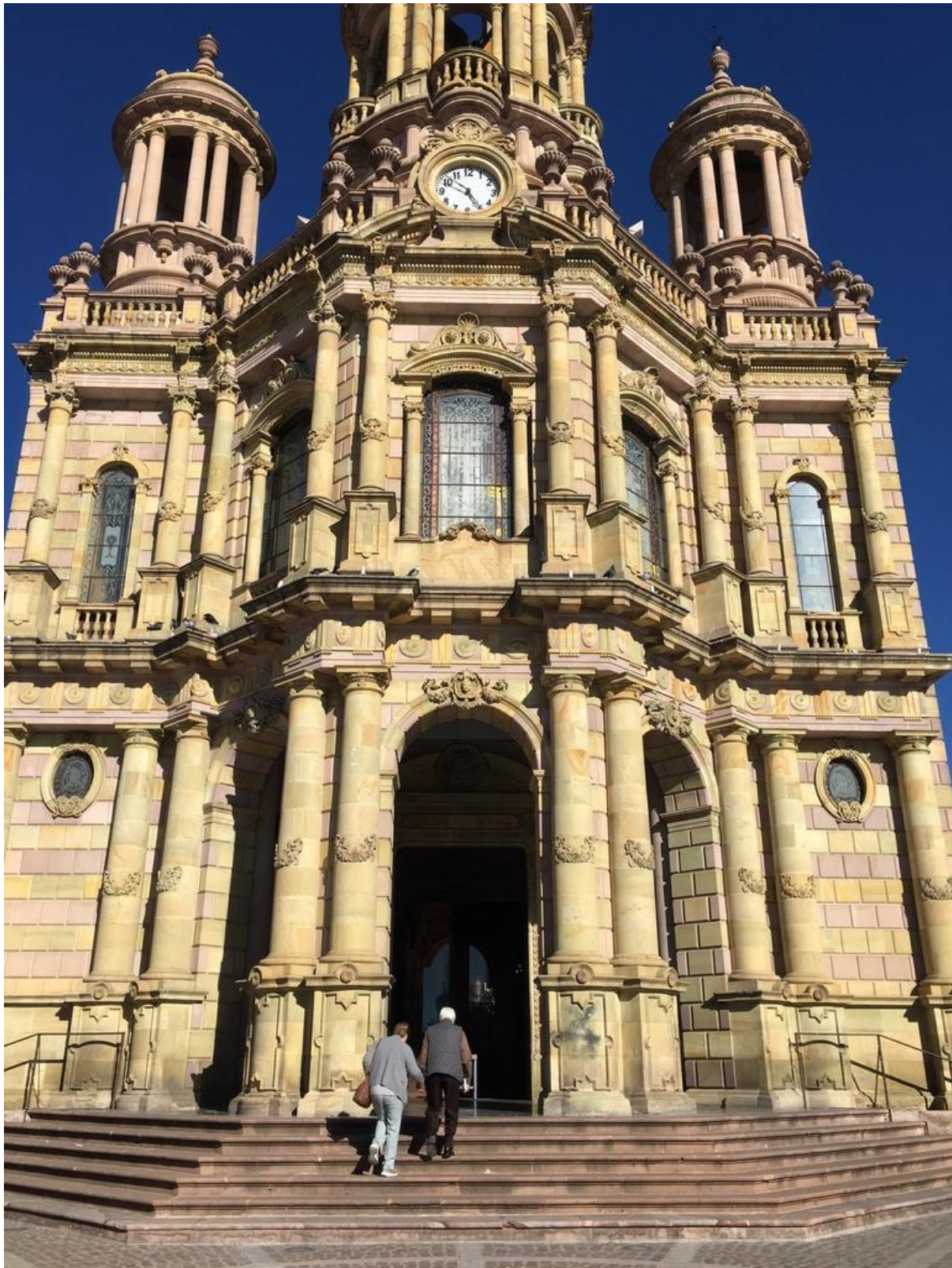
Detalle de la fachada principal.
