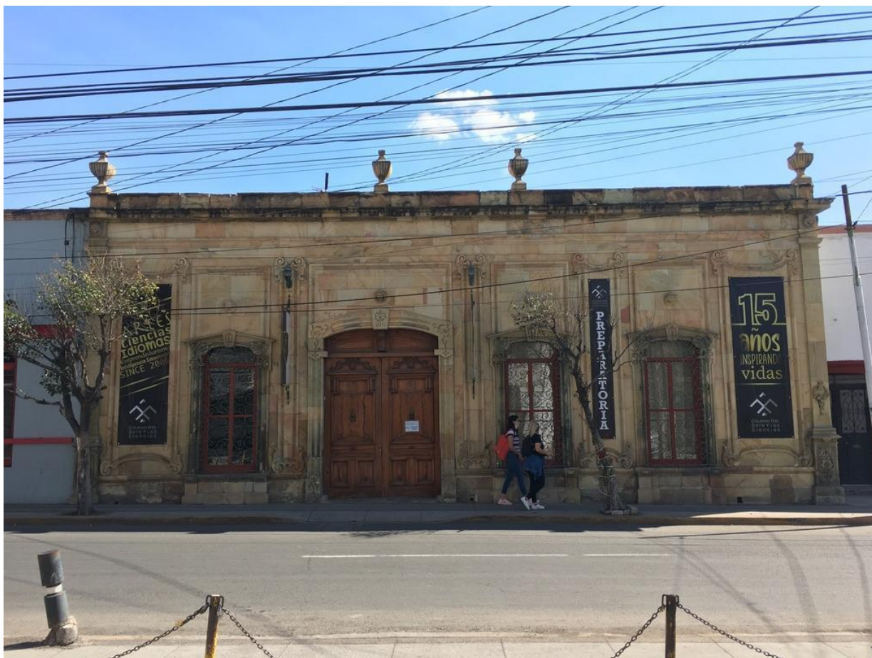
Fachada principal del edificio.
