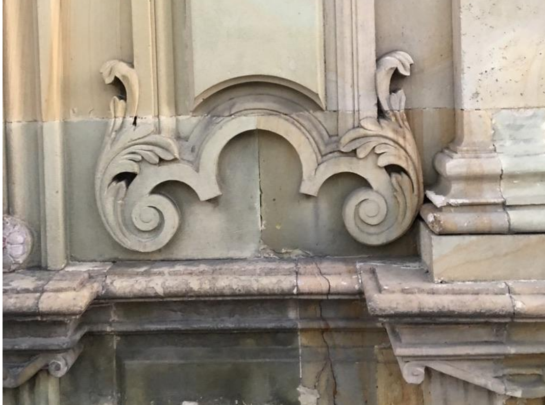
Detalle de fachada donde la cantera amarilla es la protagonista.
