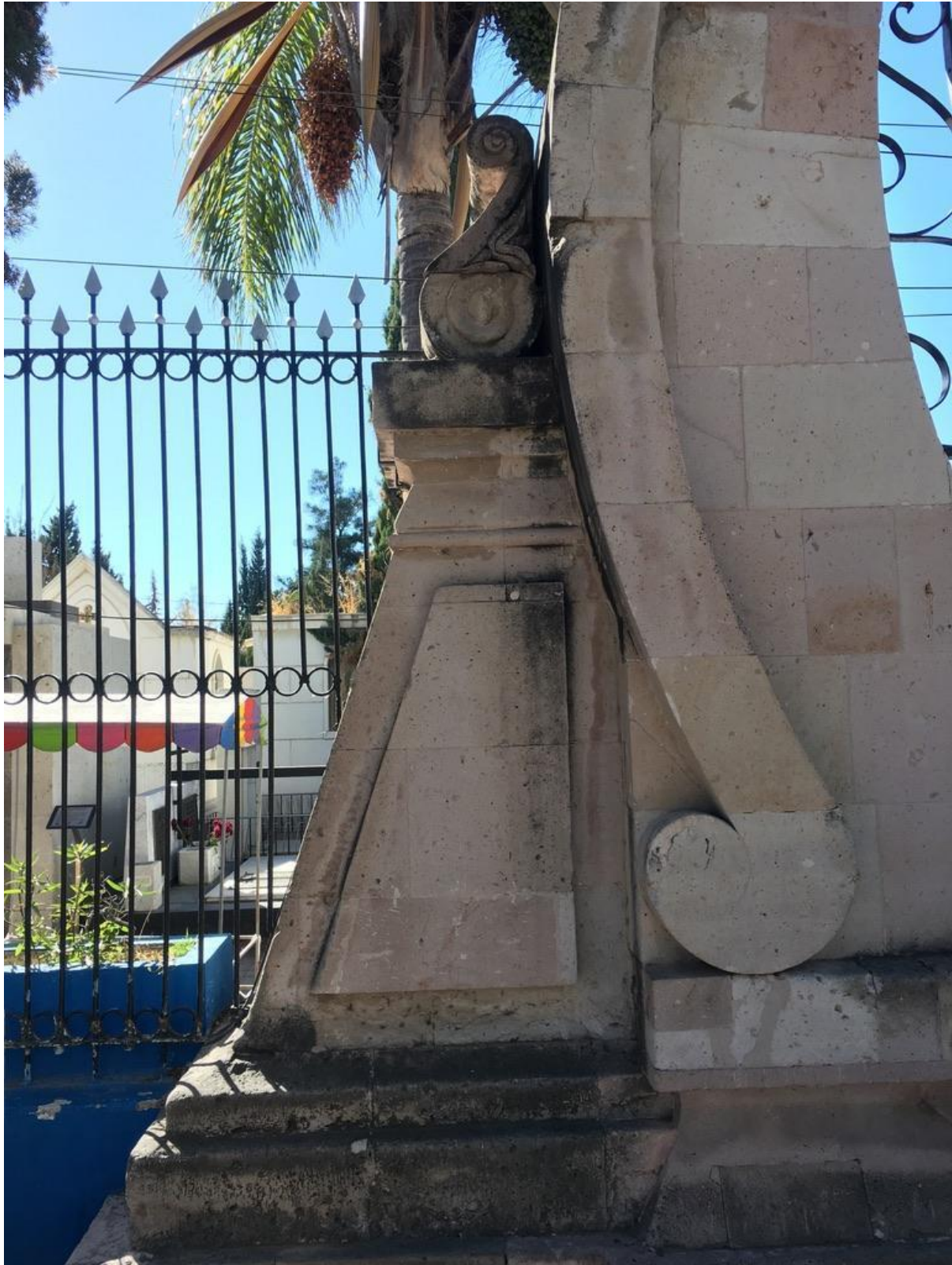
Detalle de la fachada principal.
