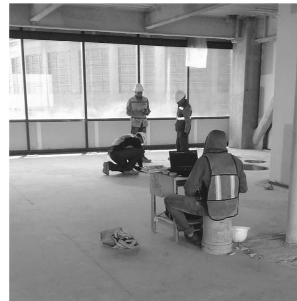
Imagen 9.3 Revisión y corrección de trazo con brigada de topografía.
