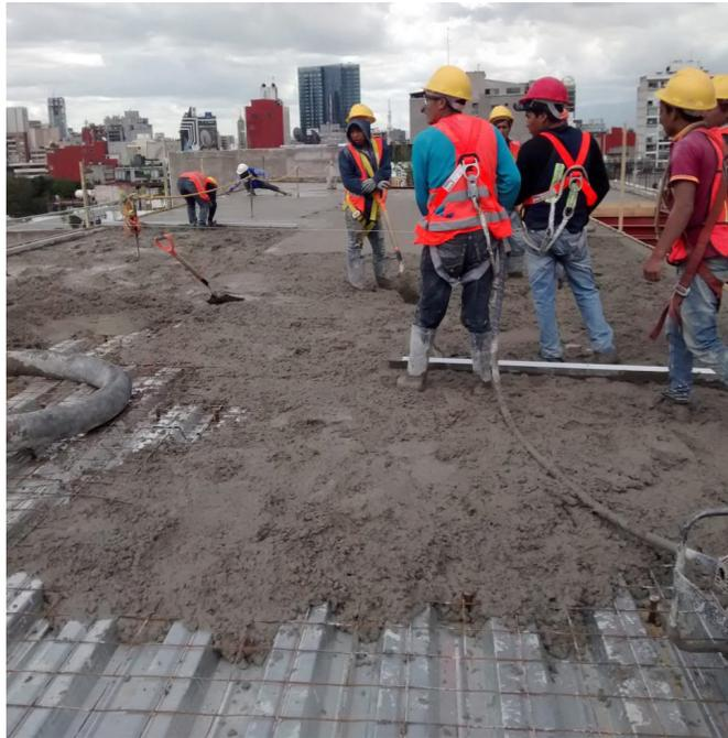
*Proceso de colado de capa de compresión con sistema constructivo de losacero.*
