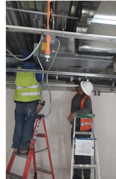
Imagen 10.21 Instalación de bombas de calor.
