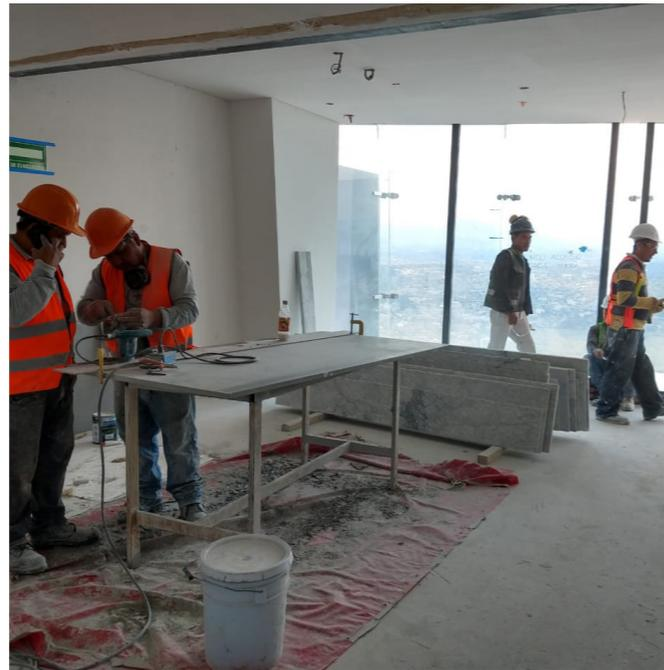
Imagen 6.4 Las placas de mármol reciben los últimos ajustes dentro del área de instalación.
