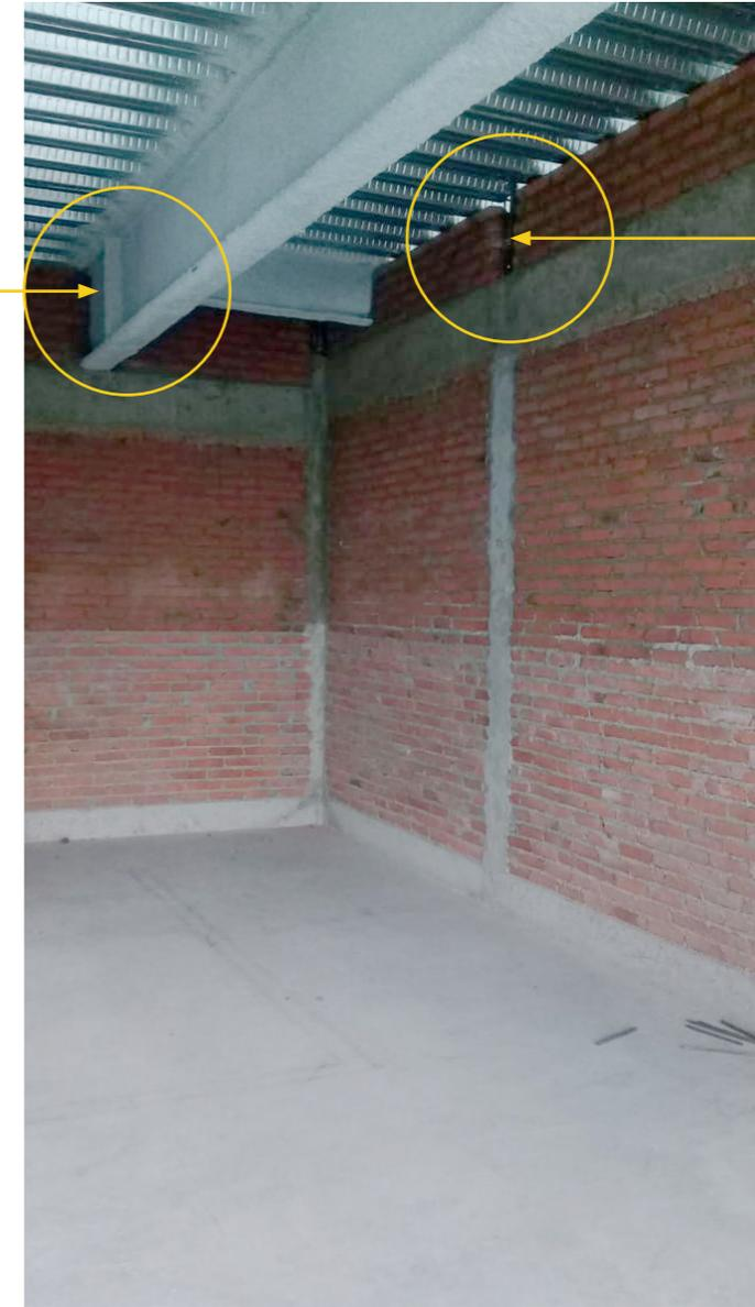
Muro TRR con preparación del paso de estructura para posteriormente darle tratamiento acústico.
