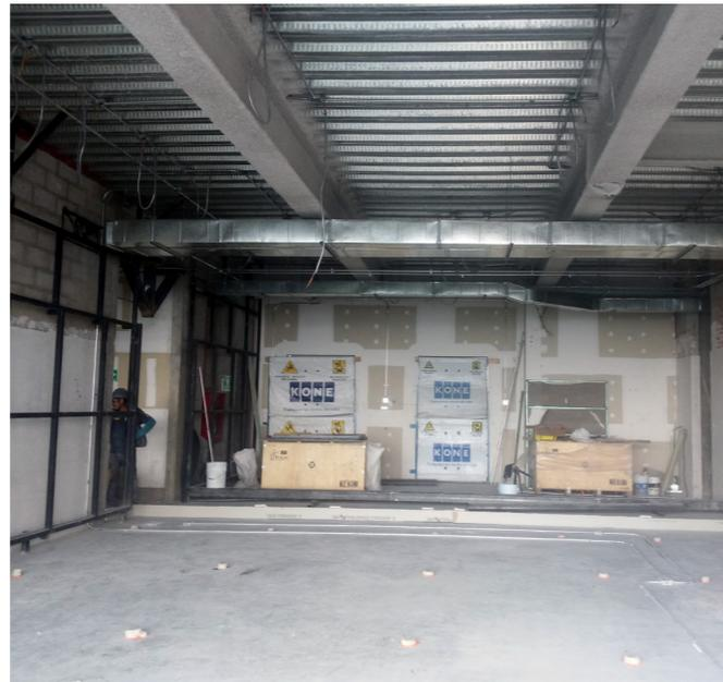
Imagen 10.25 Instalación de ductos de inyección de aire.
