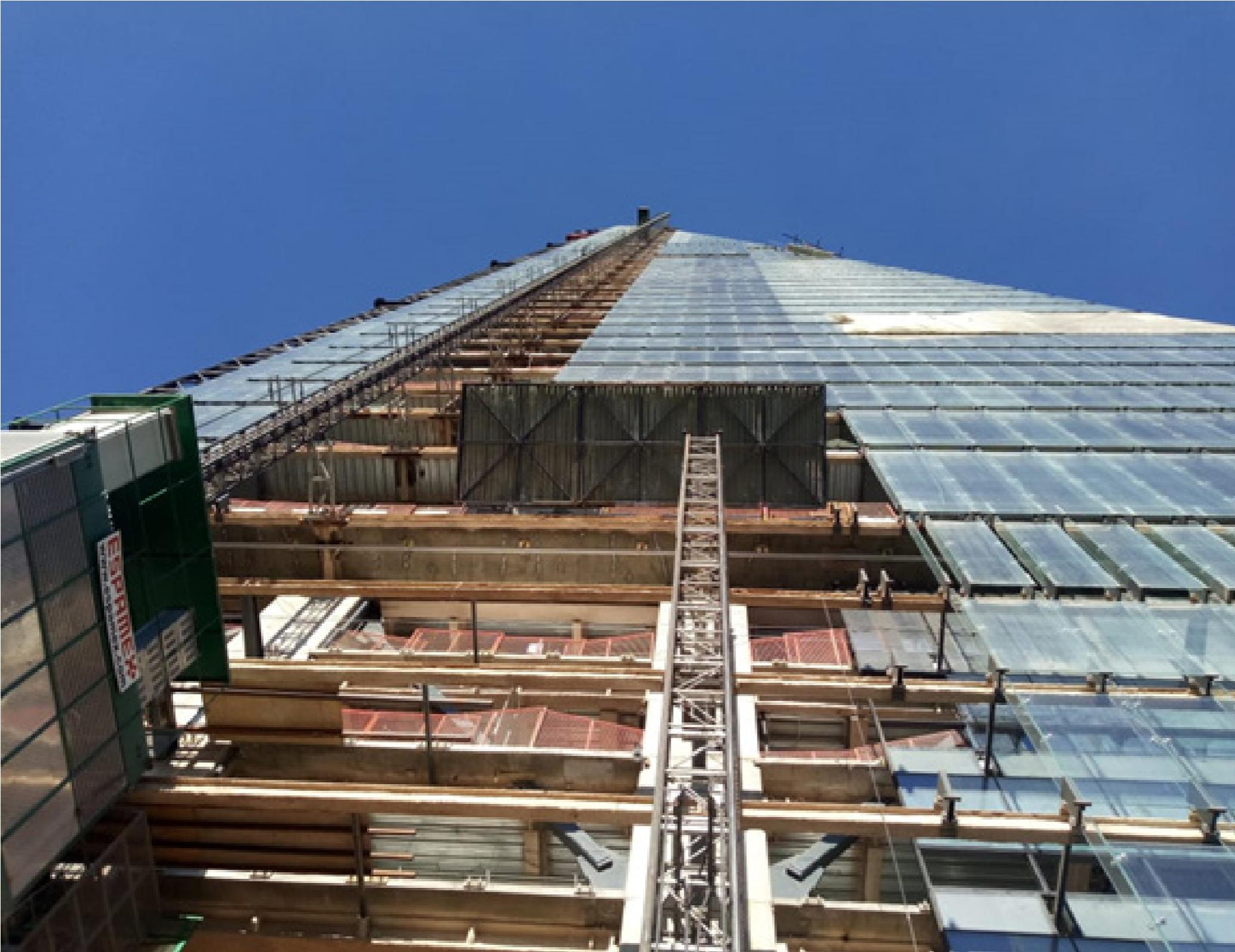
*Imagen 6.9 El cuerpo de elevadores E1 recorta el recorrido de su viaje hasta el N9 para permitir el ensamblaje de la fachada de cristal.*
