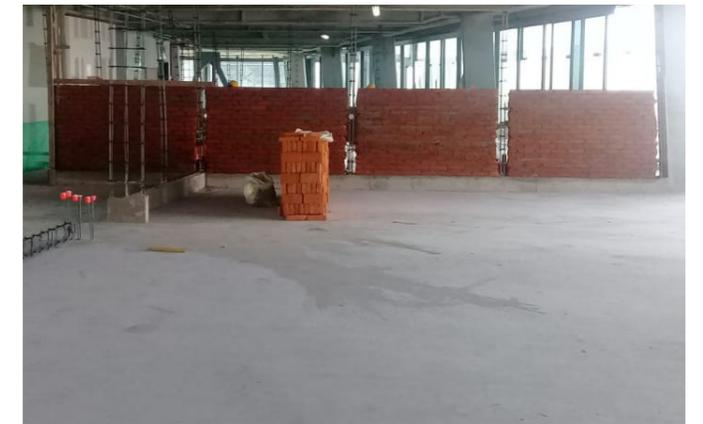
*Imagen 9.9 Proceso de construcción de muro a base de tabique rojo recocido.*
