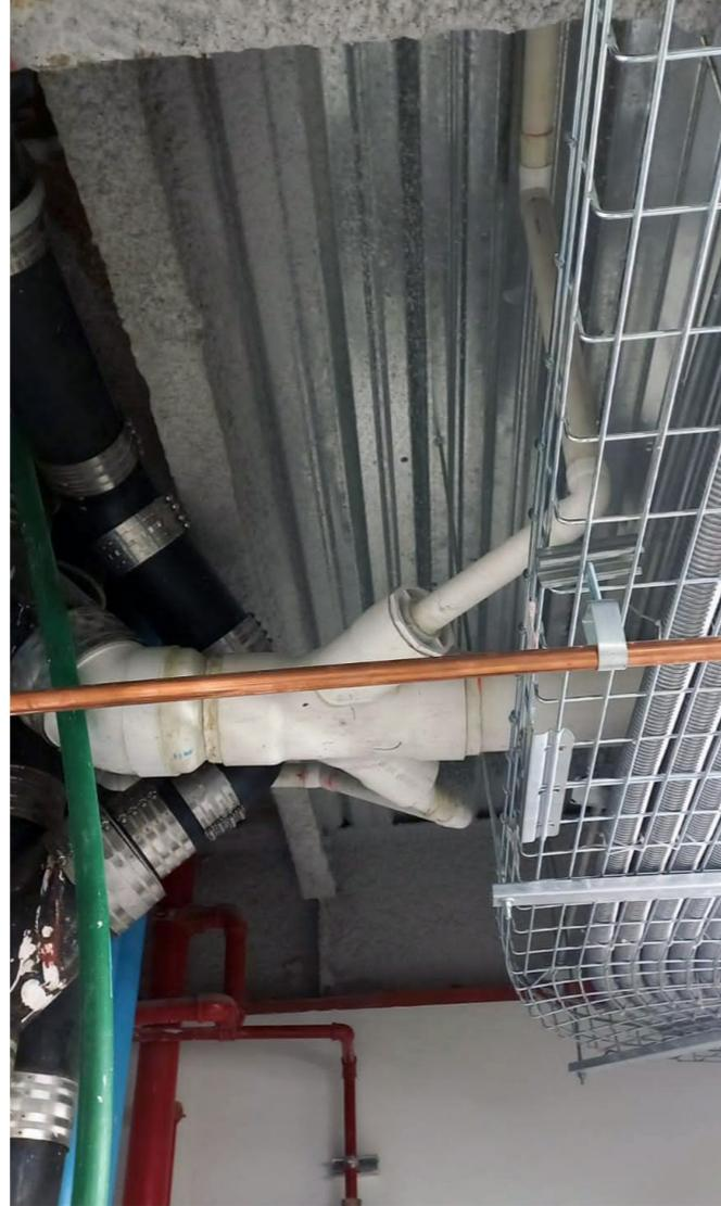
Imagen 10.10 Conexión de ventilas.
