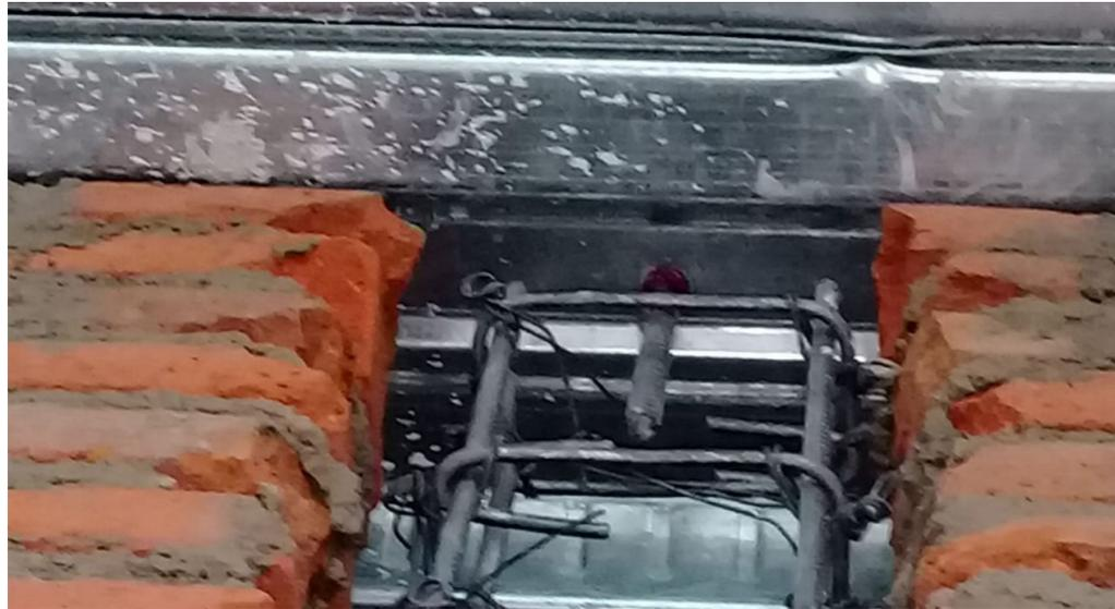
Imagen 9.10 Preparación para anclajes epóxicos en losacero.
