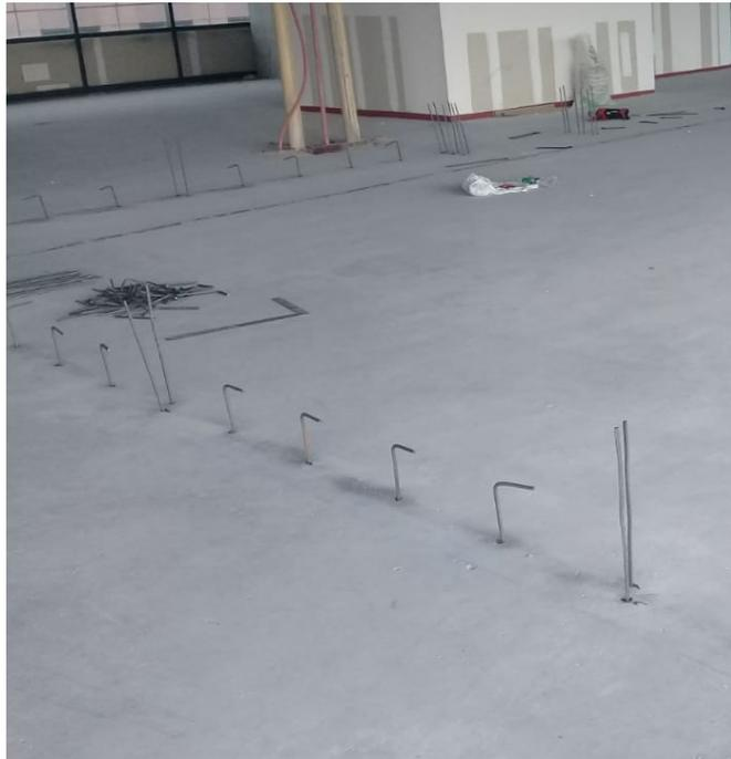
*Imagen 9.5 Instalación de anclajes epóxicos.*
