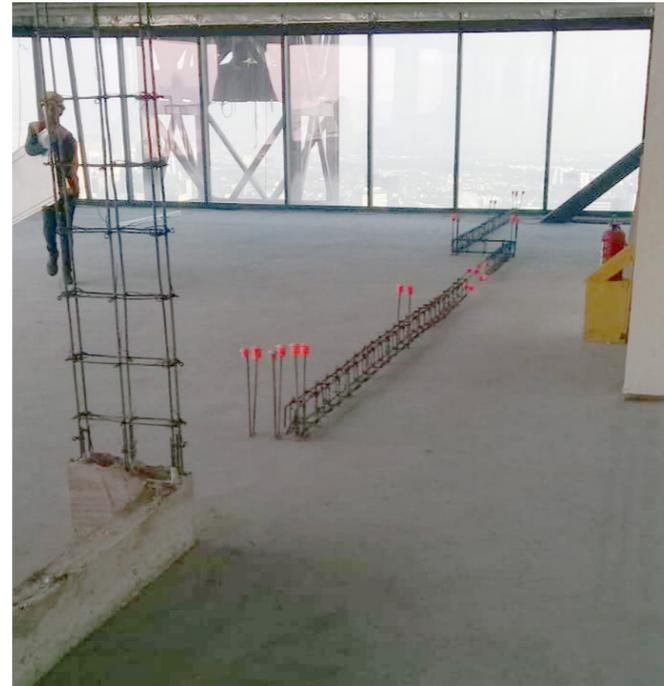
*Imagen 9.6 Proceso de armado de dalas de desplante y castillos.*
