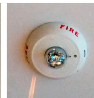
Imagen 10.35 Alarma y luz estroboscópica en plafón.
