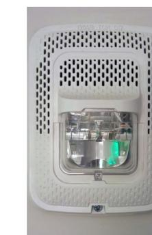
Imagen 10.37 Alarma y luz estroboscópica en muro.
