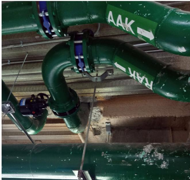
Imagen 10.24 Cabezales del sistema de agua helada.
