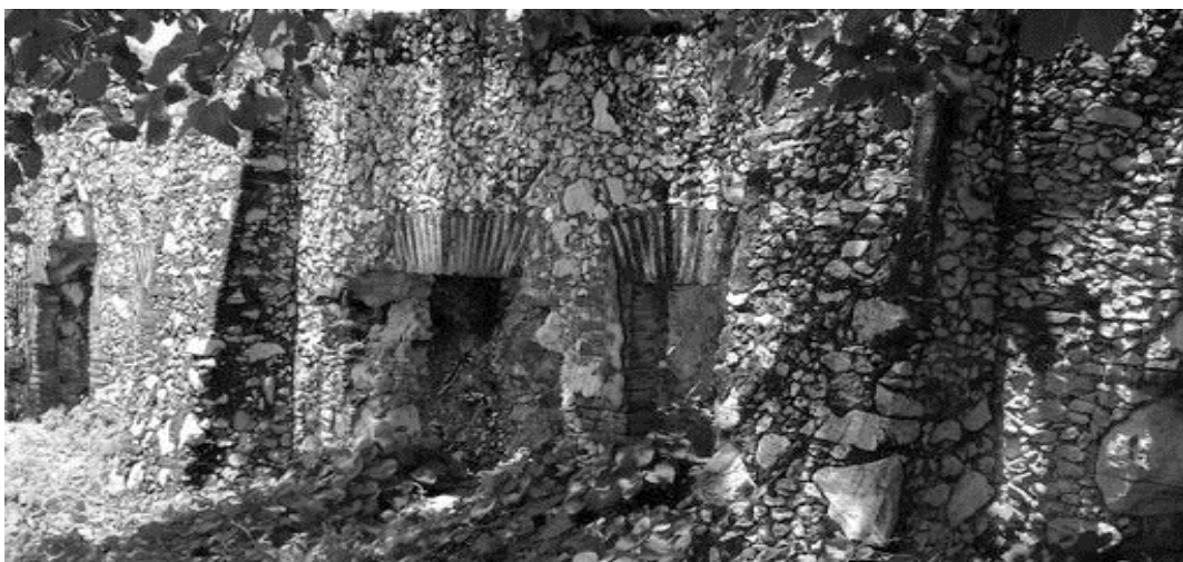
[Imagen I.2] Ruinas de la tienda de Anenecuilco.
