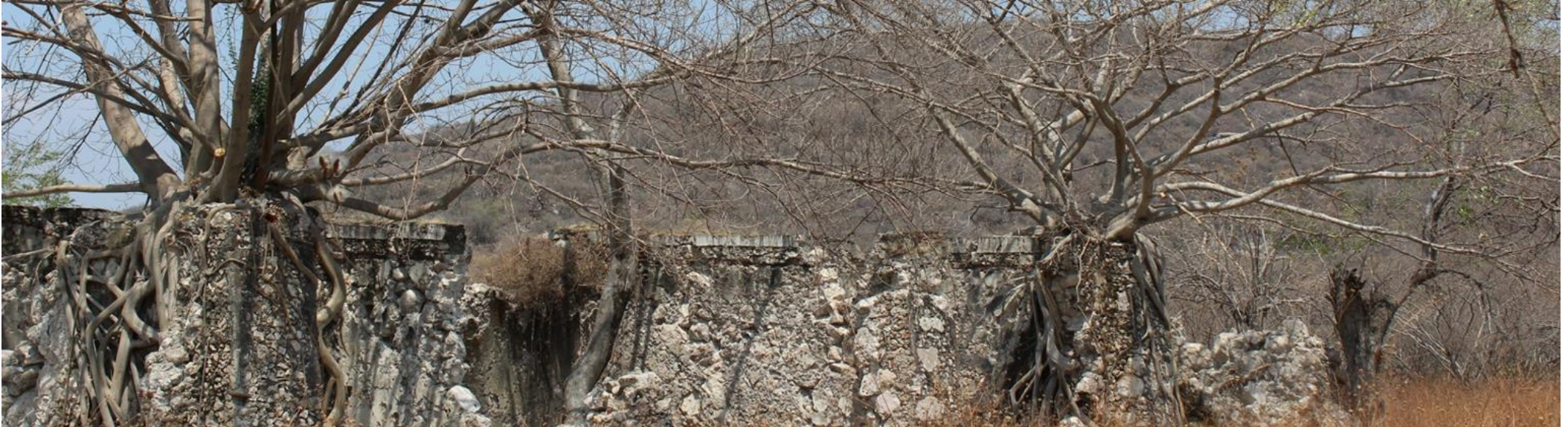
[Imagen III.1] Vistas fachada noroeste de la Tienda de Raya en el estado actual (Fotografía) de Valeria Medina Pimentel 2019
