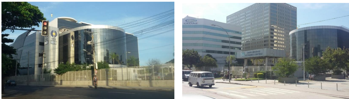
Foto 4. Fachada Exterior de Centro de Comando y Control de Río de Janeiro
