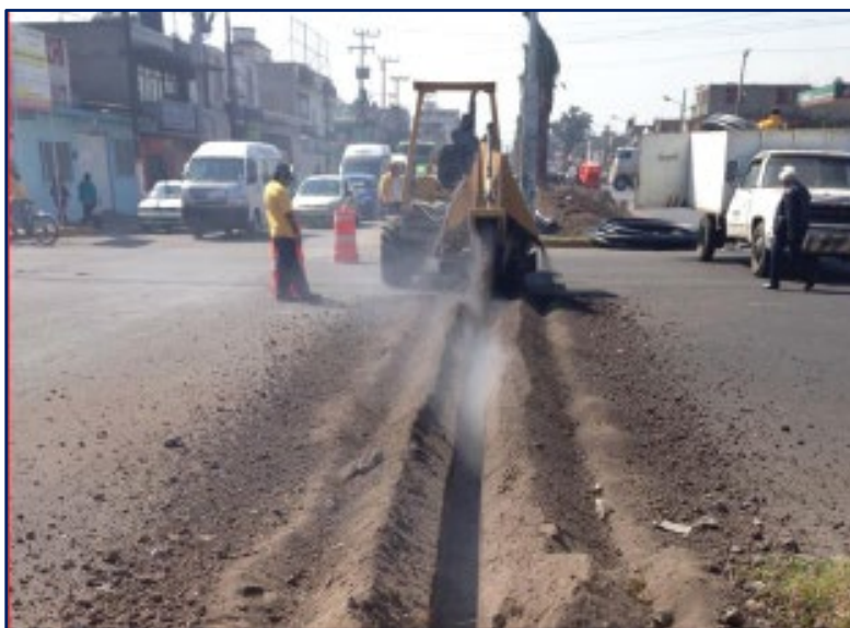
Figura 10 Reemplazo de tubería. (MAPAS)
