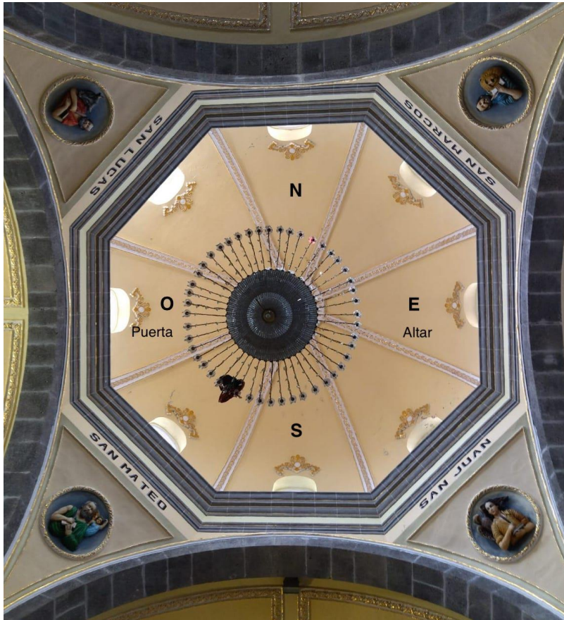
Foto 33. Pechinas del templo de San Pedro, Zacatlán, Puebla. Por lo general, son los evangelistas lo que ocupan las pechinas, las cuales arquitectónicamente ocupan los puntos intermedios que resultan del cruce de la nave con el travesaño. Coloqué las direcciones cardinales del templo para identificar las intermedias. Leopoldo Trejo, 2021.
