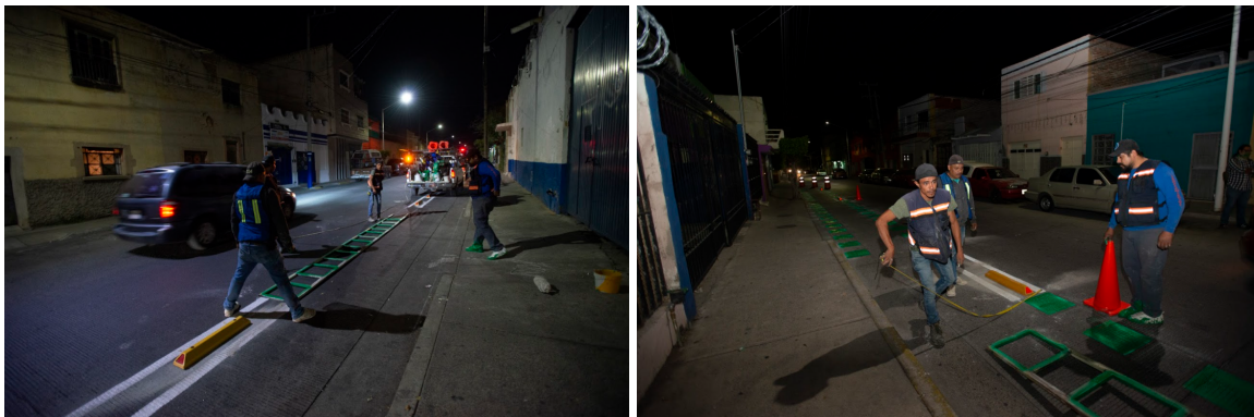
Figura 42. Fotografías de balizamiento de la ciclovía.
