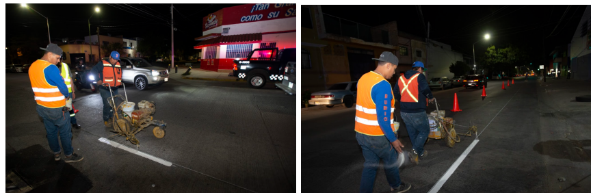
Figura 39. Fotografías de balizamiento de la ciclovía
