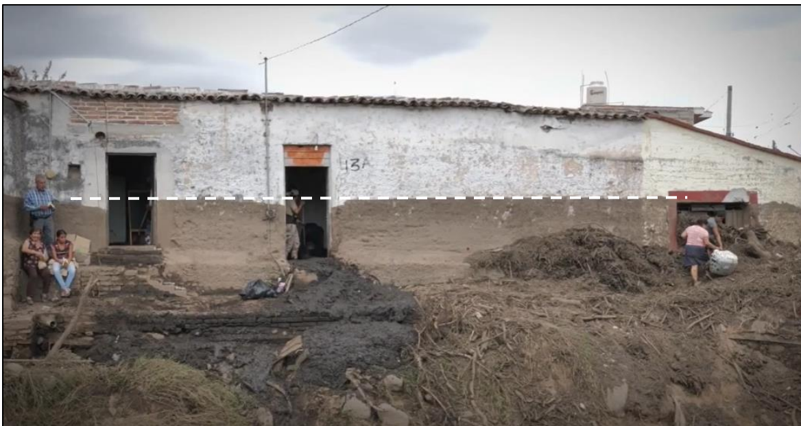
Figura 4: Imágenes que muestran los depósitos y marcas de la altura del flujo de escombros en el poblado de San Gabriel, con profundidades de hasta 6 m desde la base del canal (imágenes de videos reportados por noticieros y periódicos INFORMAFOR.MX).
