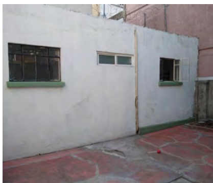
Vista desde el patio interior al espacio donde se montó la instalación.
