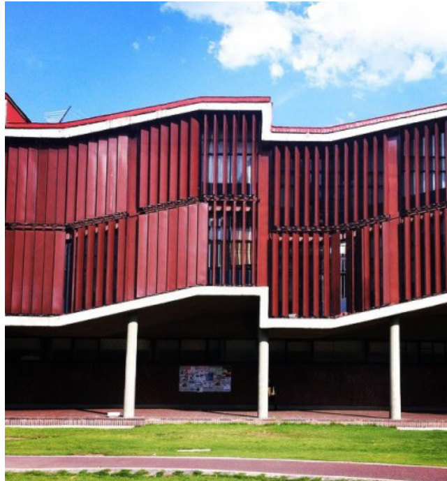
Figura 18. Fotografía de los louvers en la Fachada Oeste del edificio de Posgrado en la UNAM. (Larainne, 2015)
