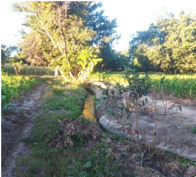
Fig. 15 Canales de riego
