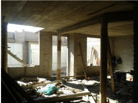
Imagen 4. Vista de losa de entrepiso terminada (autoría propia, noviembre, 2014)
