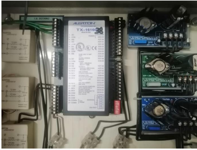
Imagen 47. Ejemplo de controlador de aplicación específica para iluminación (autoría propia)
