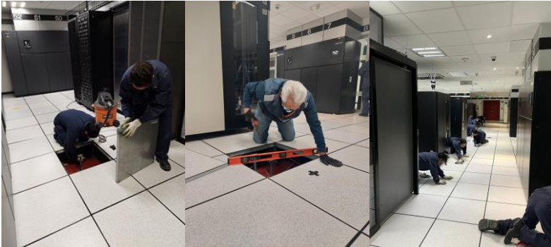
Imagen 43. La limpieza de las placas de piso falso, el proceso de nivelación y el pulido de la superficie de cada placa.
