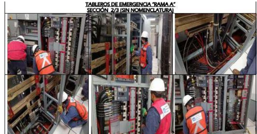
Imagen 34. Limpieza de barras y cableado de tableros de emergencia (propiedad de IEESA).
