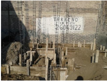
Imagen 1. Vista de la cimbra, armado de la cimentación, las puntas de los castillos armados se ahogaron en la cimentación y que eran parte de la estructura de los muros de planta baja (autoría propia, septiembre 2014).
