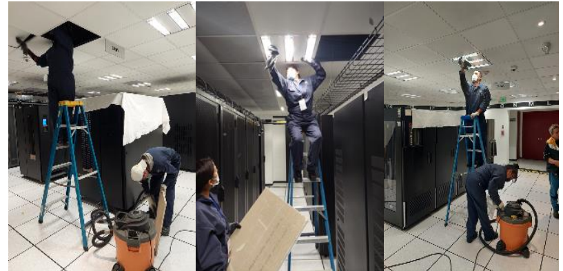
Imagen 42. Podemos observar parte de la limpieza que se realizó en las luminarias, placas y accesorios montados en el plafón suspendido.
