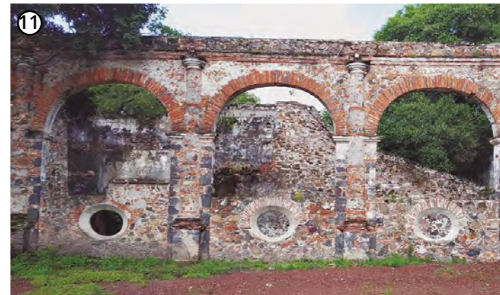
Fachada de talleres.
