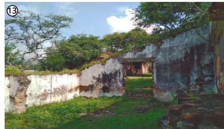
Vista interior casa de calderas.
