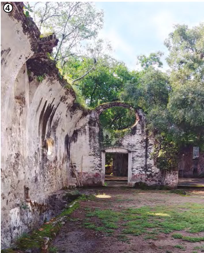
Vista interior trapiche.
