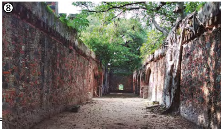
Vista interior purgares.
