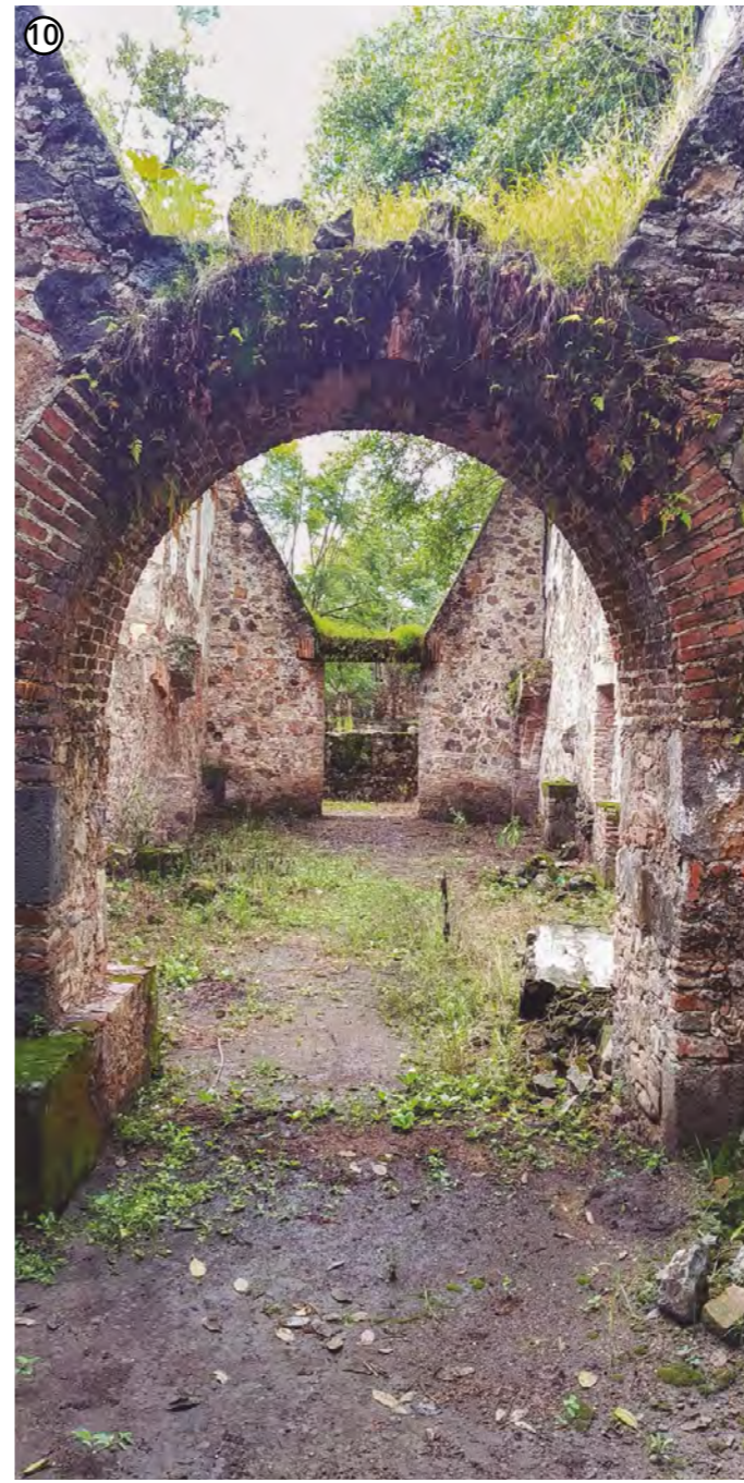
Vista interior bodegas.
