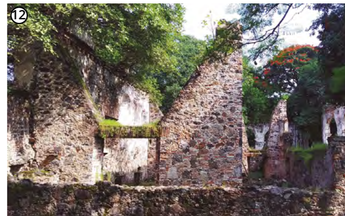
Vista interior bodegas.
