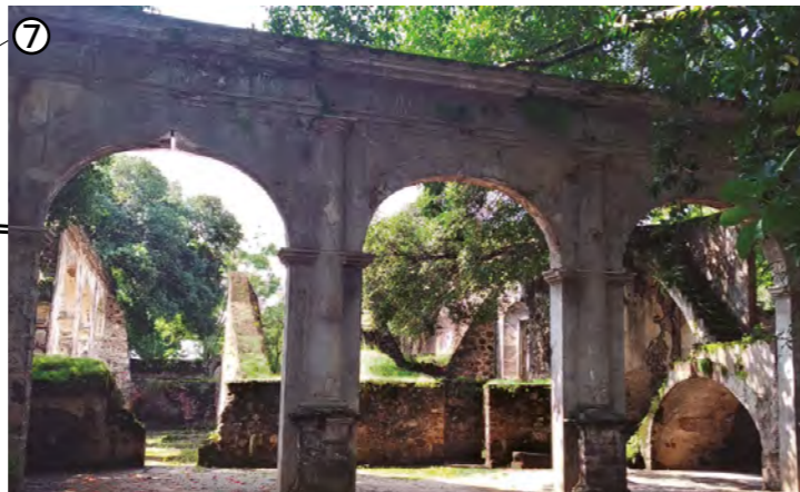
Vista interior bodegas.
