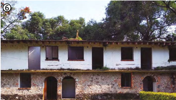
Fachada construcción posterior.
