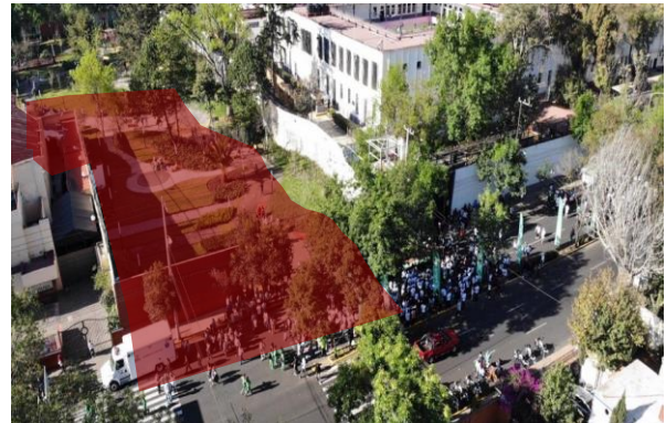
Vista aérea de (CTEA) San Fernando antes de la intervención, Tlalpan, CDMX. Fuente: (Google Maps, 2022)
