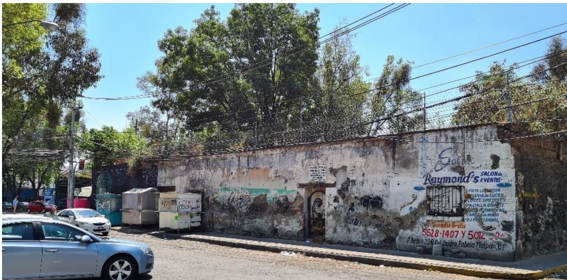
Vista desde Calle San Pedro Apóstol hacia fachada Norte Fuente: (Elaboración propia, 2022)
