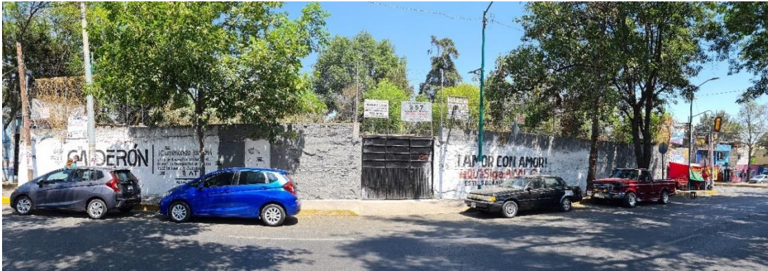
Vista desde Av. San Fernando hacia fachada Sur, acceso principal Fuente: (Elaboración propia, 2022)
