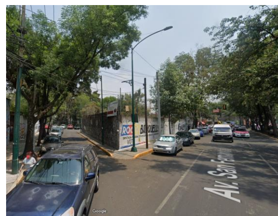
Red de suministro eléctrico, en la esquina suroeste del predio a intervenir. Fuente: Google Maps
