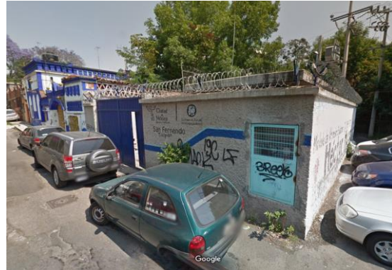
Pozo de agua en vía San Fernando. Fuente: Google Maps
