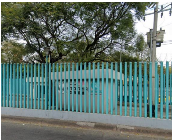
Pozo de agua Fuente: Google Maps
