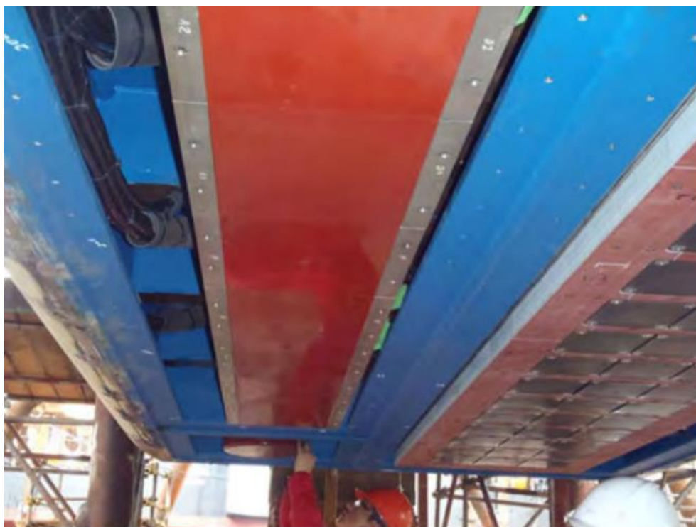
Figura 19 Instalación por el método de góndola.
