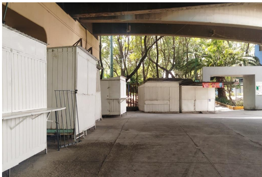
Figura 83. Bajo puente y acceso principal al Parque Tacuba.
