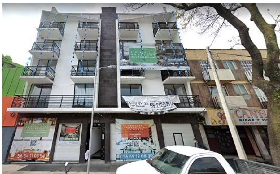
Figura 71. Nuevo desarrollo de vivienda próximo al metro Tacuba.
