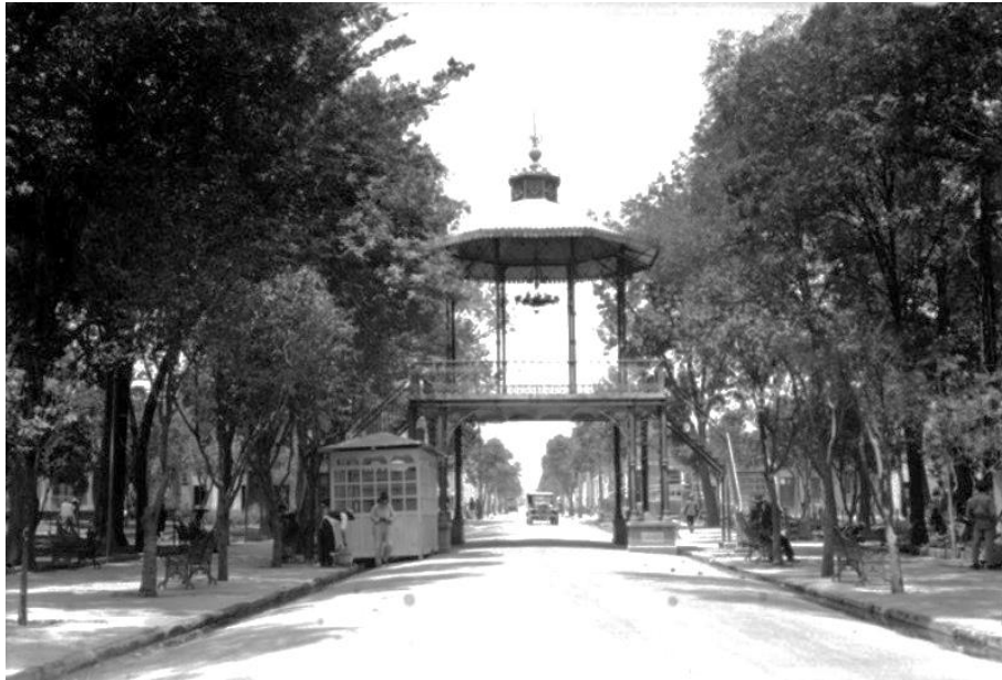
Figura 30. Kiosco y puente en una calle de Azcapotzalco.
