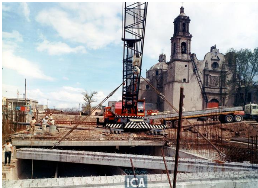
Figura 34. Construcción de la Línea 2 del metro en el área de la plaza de Tacuba.
