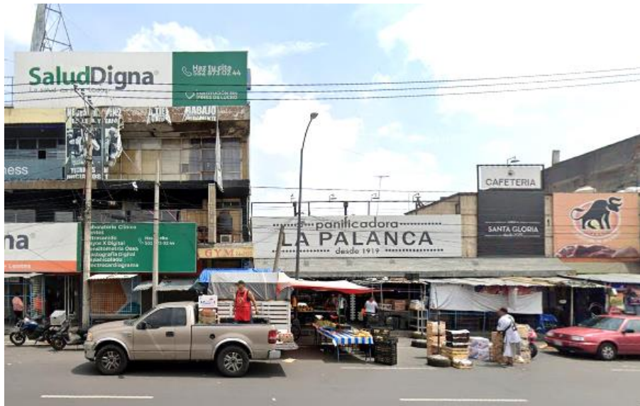
Figura 64. Prototipo de fachadas disruptoras en el espacio de Tacuba, Calzada México Tacuba.
