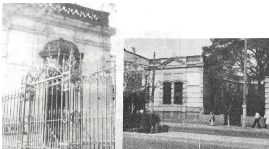
Figura 40. Fachada en Eje 3 Norte Manuel Acuña 13 en 1987.
