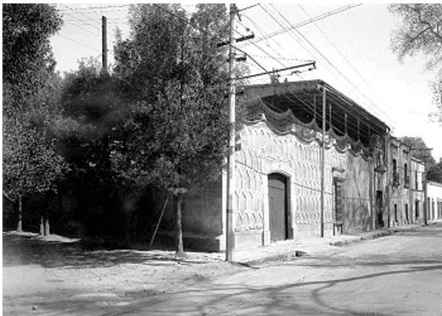
Figura 36. Casa habitación de la colonia Coyoacán en 1928.
