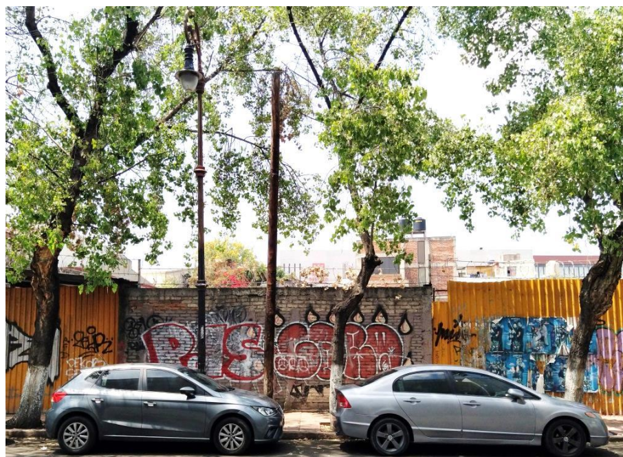
Figura 43. Fachada actual en Av. Azcapotzalco 520.
