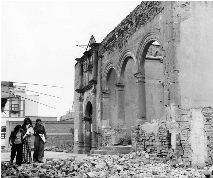
Figura 38. Demolición parcial de Capilla de la Inmaculada Concepción en 1975.
