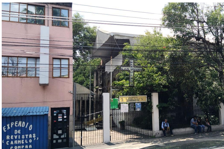
Figura 39. Estado actual de Capilla de la Inmaculada Concepción.
