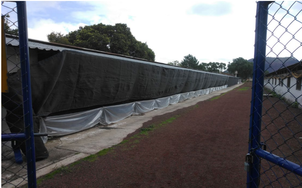
FIGURA 16. Vista exterior del aislamiento con plástico en la caseta de los sistemas de jaulas.
