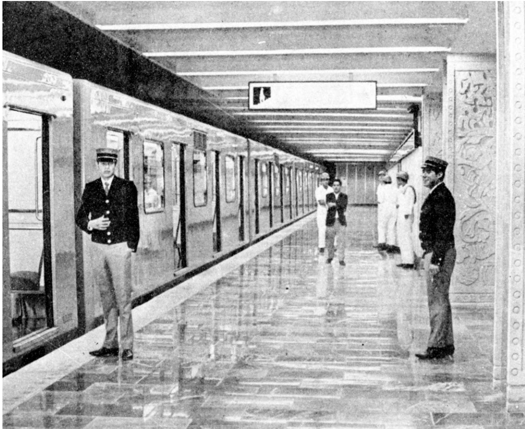
Figura 69 .Andén de la estación Metro Insurgentes, 1969. Fuente: Colección Villasana- Torres (2016) La Glorieta del Metro Insurgentes. El Universal. Recuperada de: https://www.eluniversal.com.mx/galeria/metropoli/cdmx/2016/07/3/ciudad-en-el-tiempo-la-glorieta-del-metro-insurgentes
