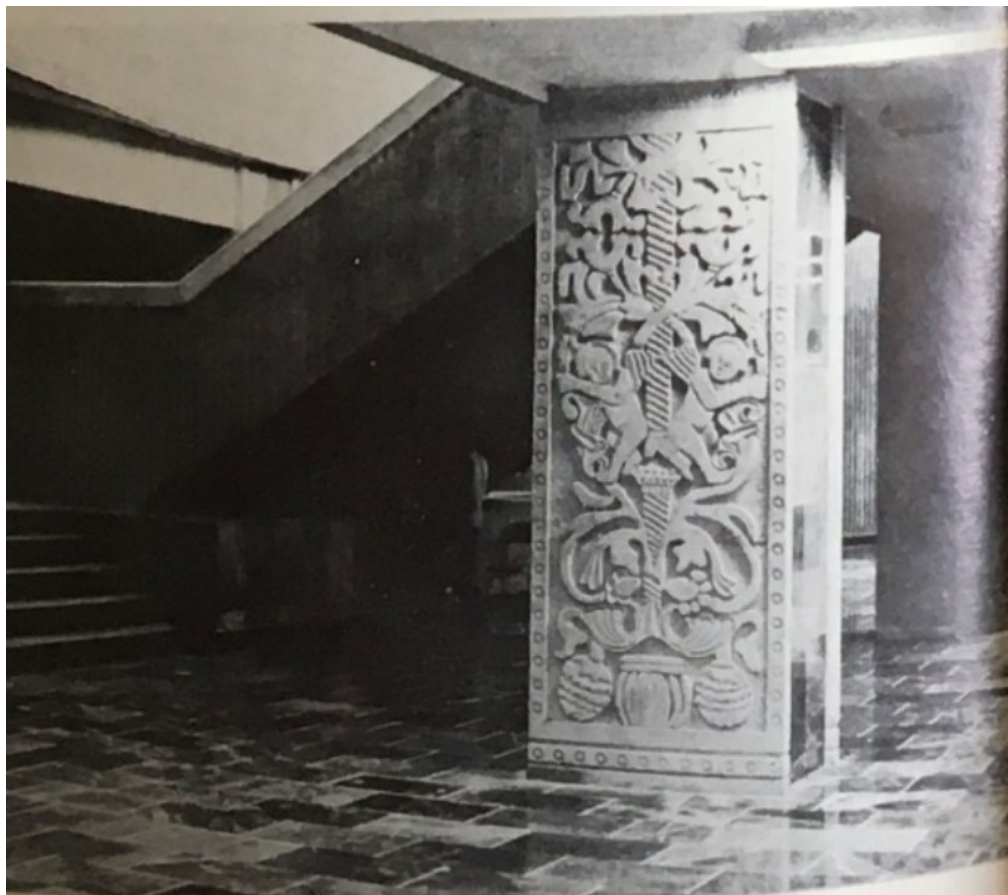
Figura 68. Columna recubierta con relieves de concreto, 1969. Fuente: Departamento del Distrito Federal, La gran ciudad, 1966-1970, (México: Departamento del Distrito Federal, 1970) 163
