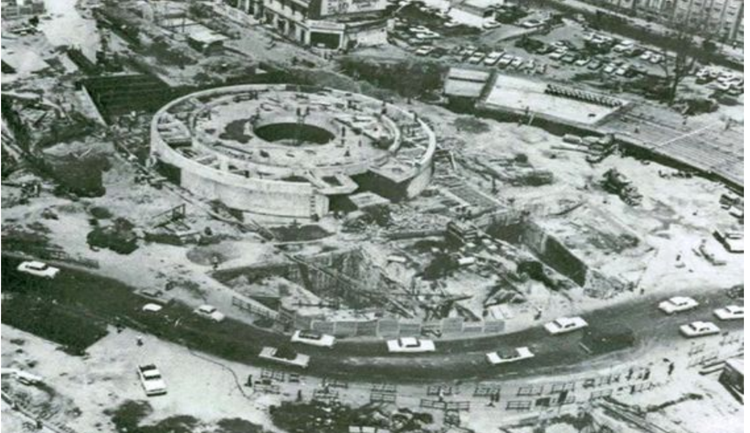
Figura 62. Toma aérea de la construcción de Glorieta de los Insurgentes, 1968. Fuente: Acervo Fundación ICA. Recuperada de: http://www.fundacion-ica.org.mx/colecciones_digitalizadas
