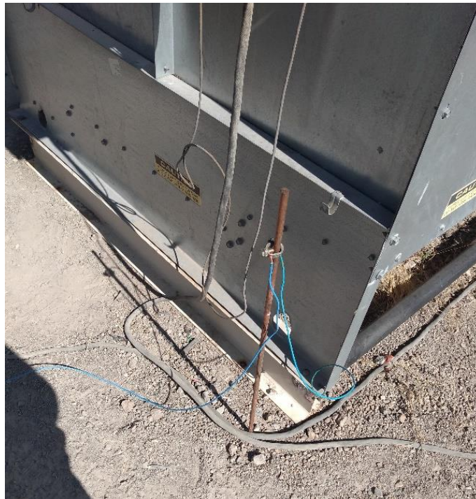
Figura 58. Proceso de instalación de tierra
