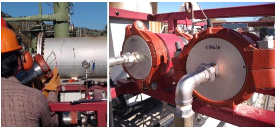
Figura 73. Reemplazo del generador N171005
