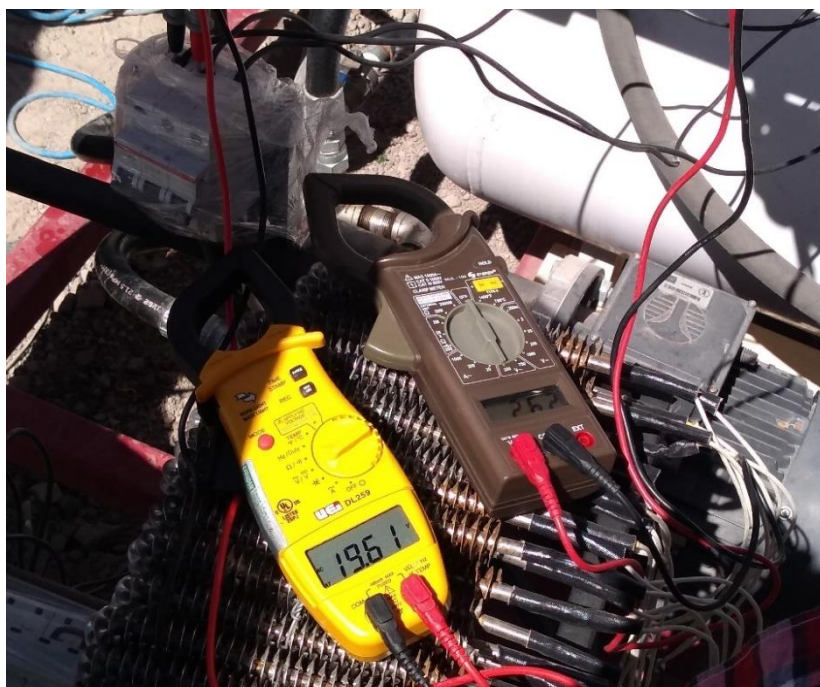
Figura 74. Toma de tensiones en vacío de los generadores
