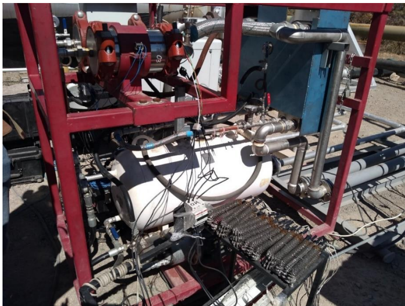
Figura 83. Pruebas de eficiencia de generadores en campo
