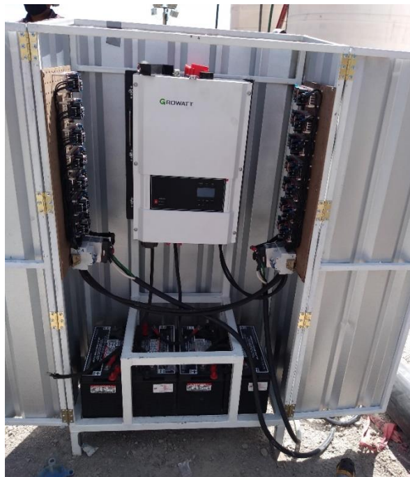
Figura 70. Montaje del panel eléctrico
