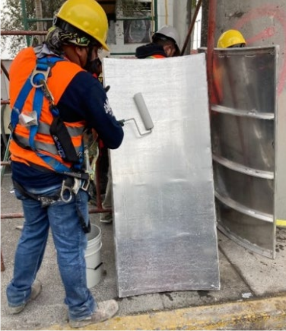
Imagen 31 Preparación y colocación de la cimbra de la columna.
