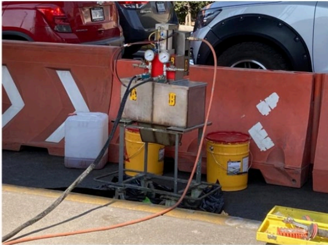
Imagen 26 Maquina para inyectar resina epoxica.
