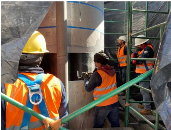
Imagen 39 Confirmación de la adherencia.
