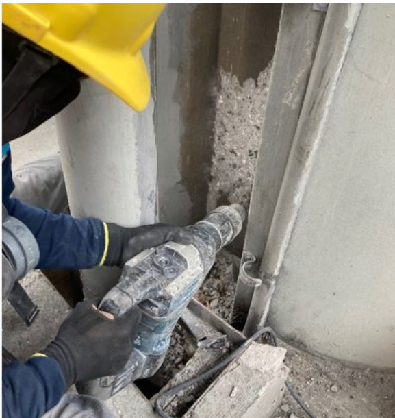
Imagen 30 Cambiando de una superficie lisa a una superficie áspera.
