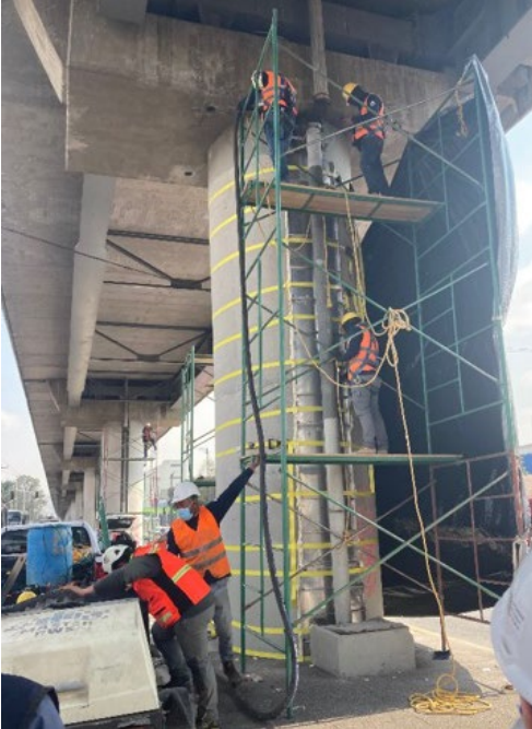
Imagen 34 Llenado de espacio liberado en la columna.
