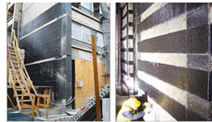
Imagen 9 Aplicación de Fibra de Carbono en muros de concreto (viga).
