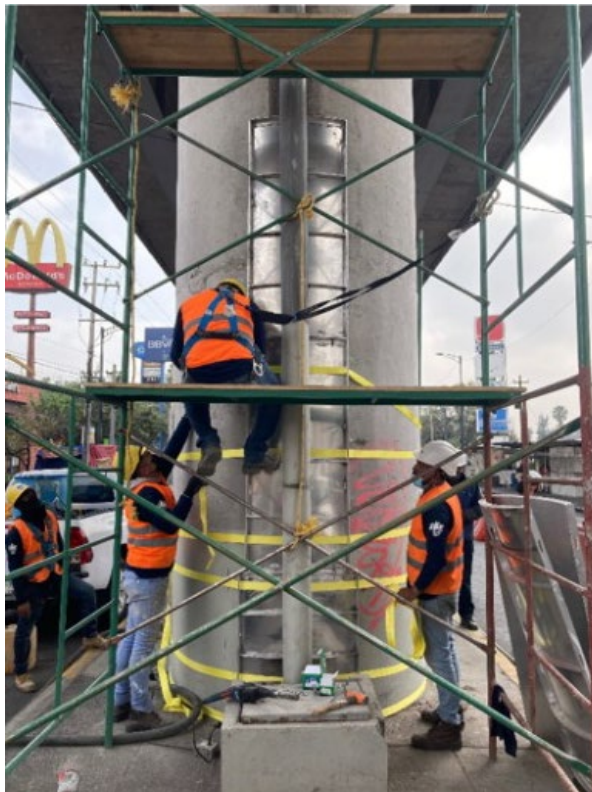
Imagen 32 Fijación de cimbra en la columna.
