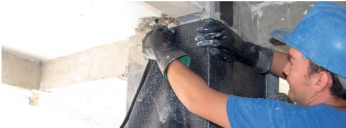
Imagen 14 Instalación de Fibra de Carbono horizontal en muros.
