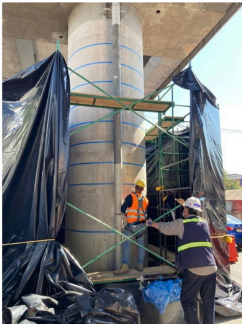
Imagen 35 Descimbrado y marcación de columna.
