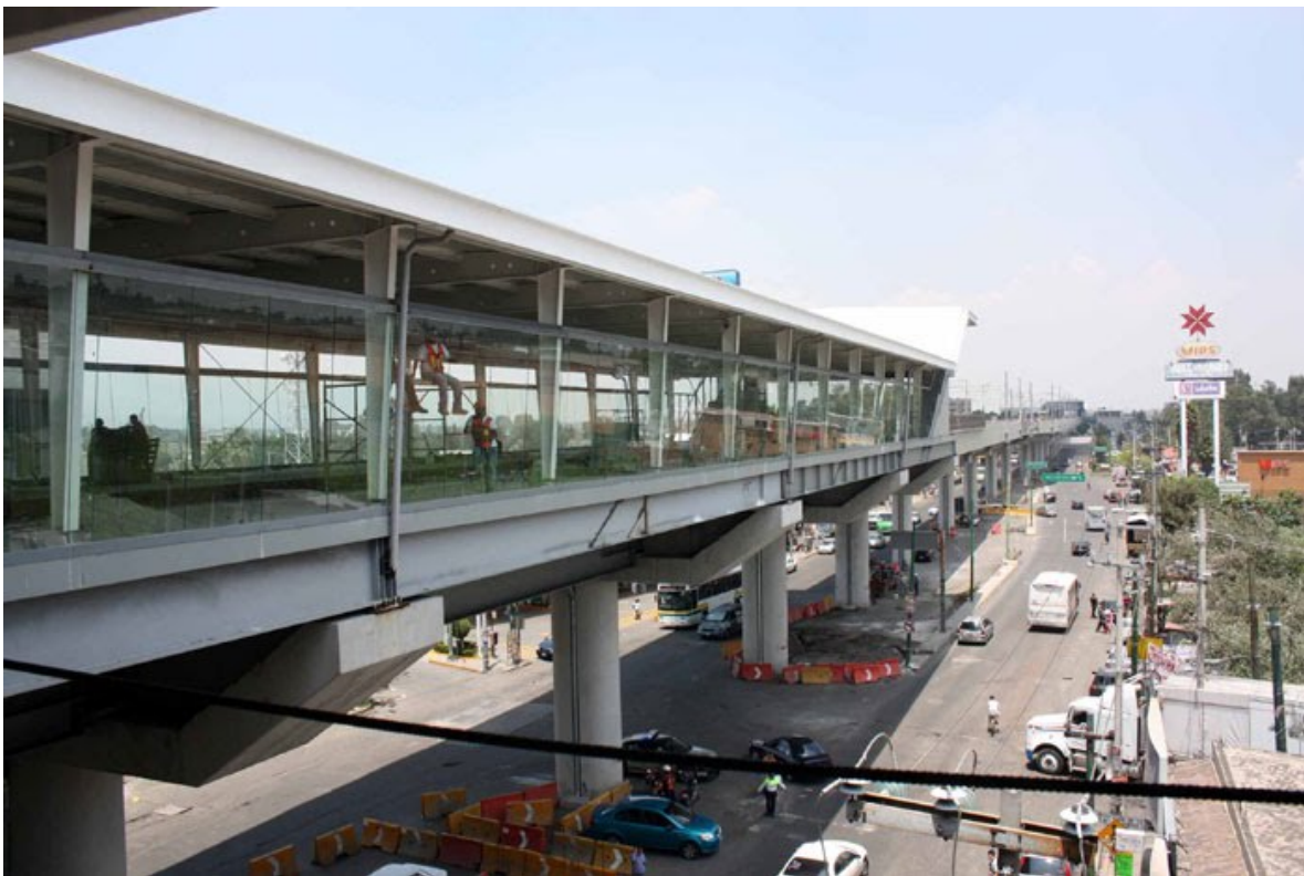
Imagen 24 Foto de la Línea 12 del metro, antes del reforzamiento de las columnas.
