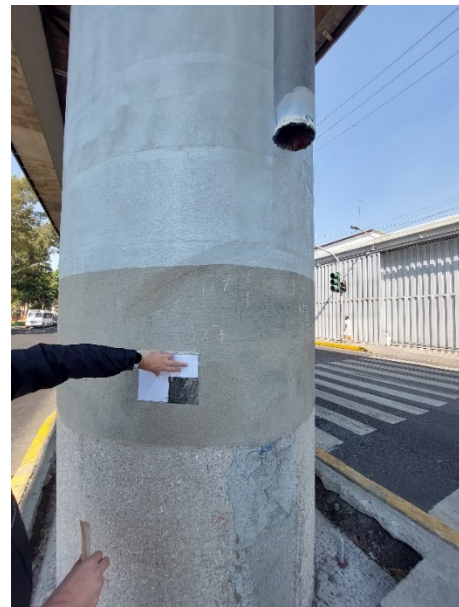
Imagen 46 Detalle de columna con acabado de arena y recubrimiento contras los rayos UV.
