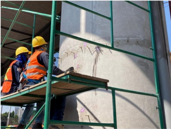
Imagen 25 Colocación puertos de inyección.
