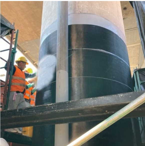
Imagen 41 Colocación de otra capa de resina sobre fibra de carbono.
