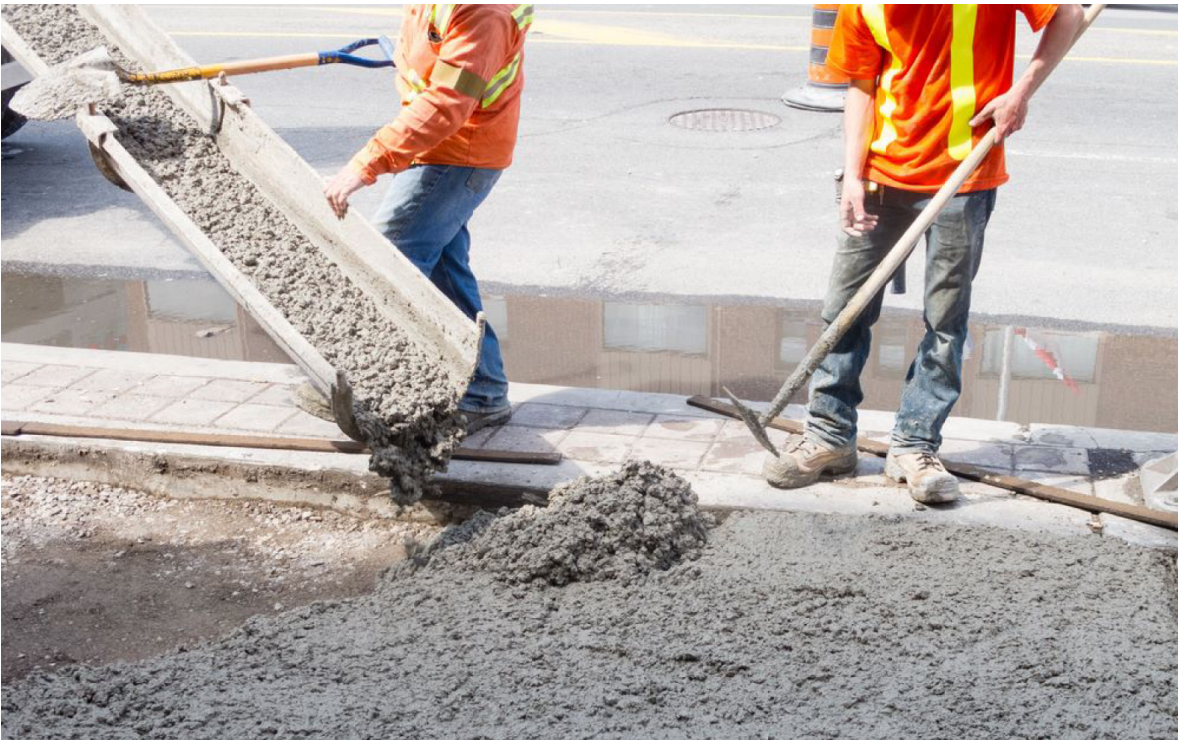
Imagen 21 Aplicación de concreto.
