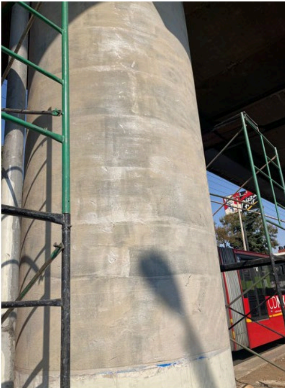
Imagen 42 Colocación de acabado rugoso.
