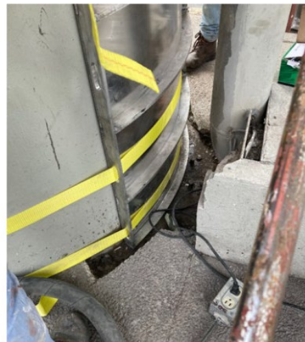
Imagen 33 Aseguramiento de la cimbra en la columna.
