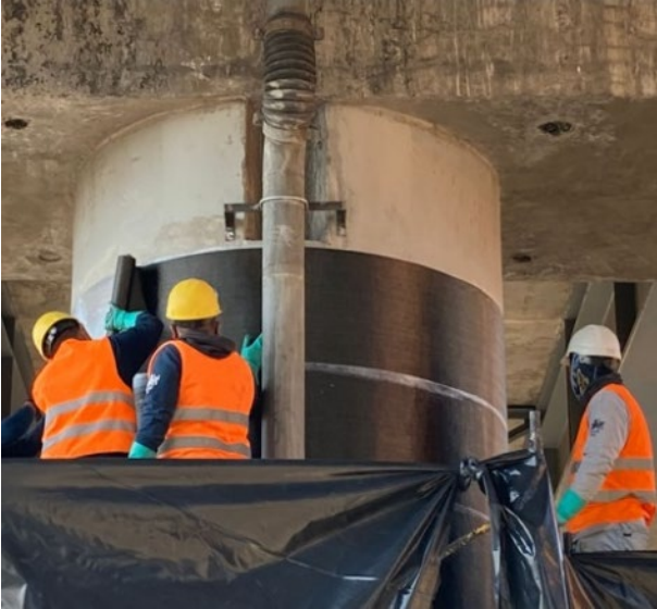
Imagen 40 Colocación de la fibra de carbono en todo lo largo.
