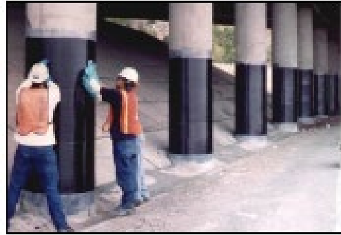
Imagen 10 Aplicación de Fibra de Carbono en columnas de concreto (viga).
