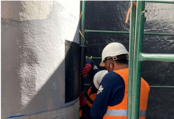
Imagen 38 Colocación de la fibra de carbono.
