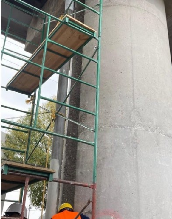
Imagen 29 Recolocación de tubería de bajada de agua.
