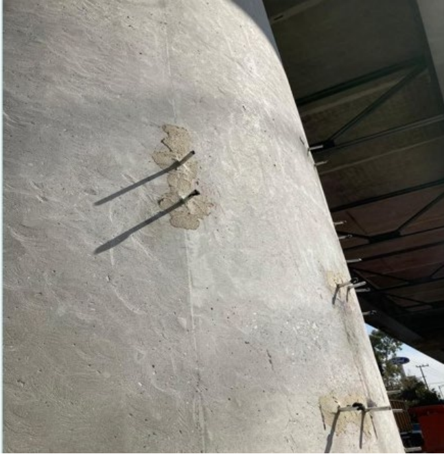
Imagen 28 Puertos de inyección después del sellado de grietas.
