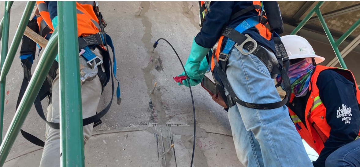
Imagen 27 Puertos de inyección de pasta epóxica para sellar grietas.
