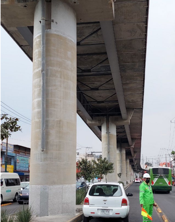
Imagen 43 Columnas con fibra de carbono y acabado rugoso.
