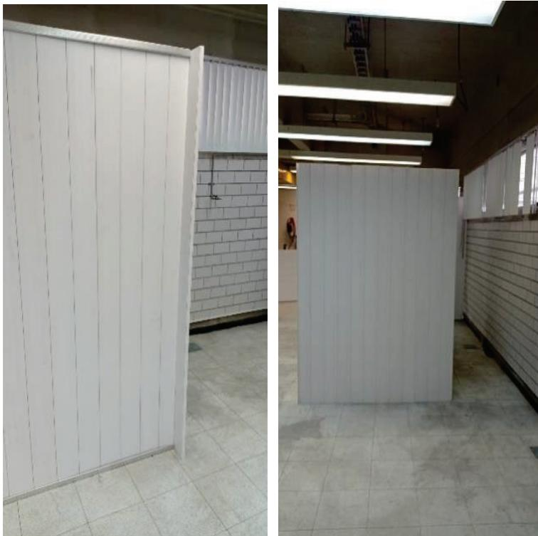
*Figura 66.- Configuración vertical de paneles.*
