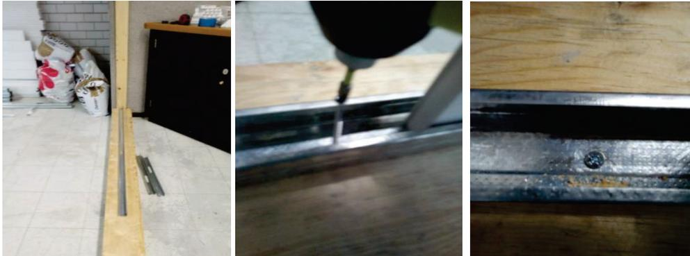
Figura 64.- Colocación de canaleta base.
