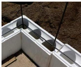
*Figura 8. Unidades modulares de poliestireno expandido con malla metálica; (Revista arch daily, 2015).*
