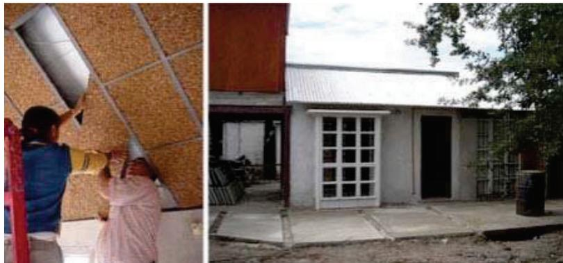
*Figura 9. Construcción a base de hormigón y plástico reciclado; (Palapa 2013).*
