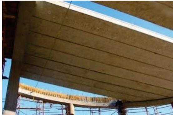
*Figura 14.- Sistema de losa prefabricada; (CSI 2021).*
