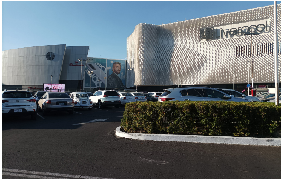
FIGURA 56. Uno de los accesos principales a Perisur, del lado de Liverpool, en donde se integra la fachada de Sanborns
