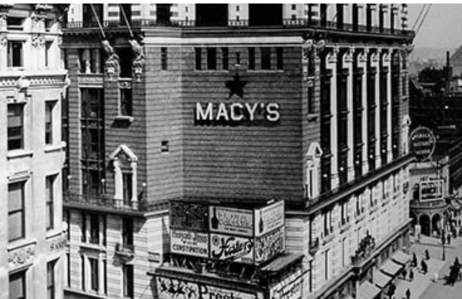
FIGURA 18. Edificio de la tienda departamental Macy's cuando fue reubicada en Nueva York
