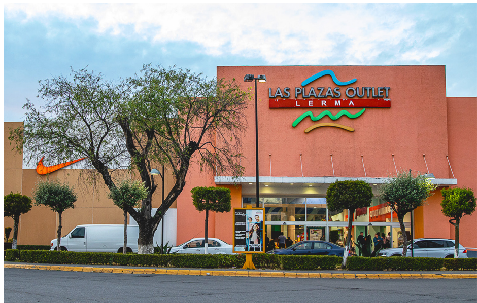
FIGURA 10. Las Plazas Outlet Lerma, uno de los primeros centros comer- ciales de salida de fábrica en México
