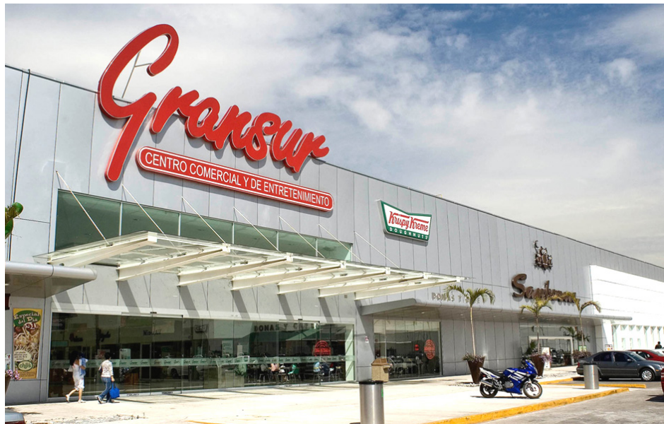
FIGURA 4. Centro comercial Gransur, un ejemplo de centro comercial comunitario
