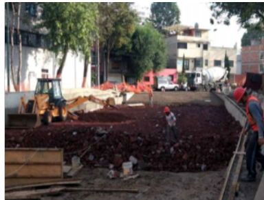
Imagen 6: Proceso de rehabilitación de la cancha.
