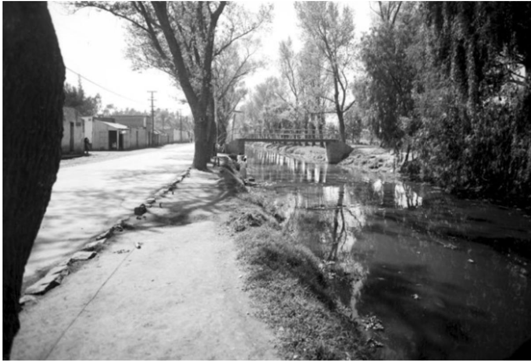
Figura 2. Canal de la Viga, vista parcial [7] .
