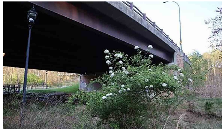
Fig. 3.13. Bajo el viaducto de Montrose. Fotografía digital. Mayo 2021.
