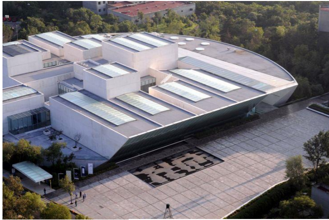
5.3 Vista aérea del edificio
