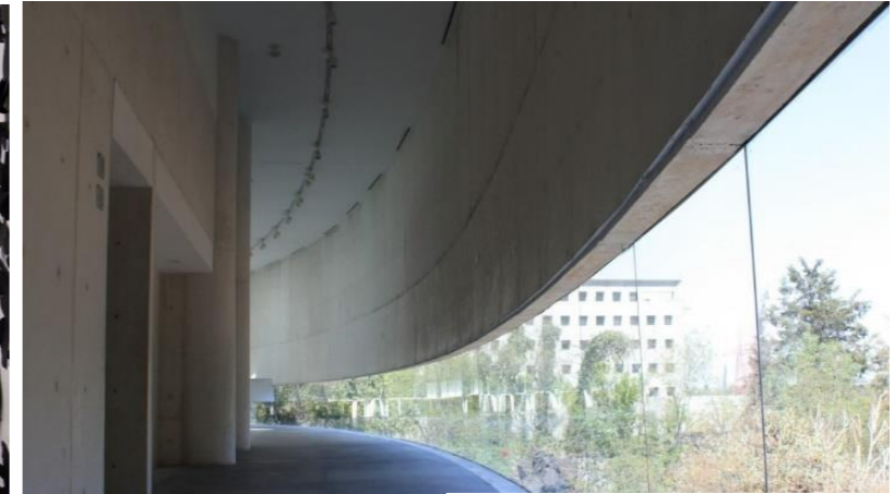
5.8 Corredor en planta alta
