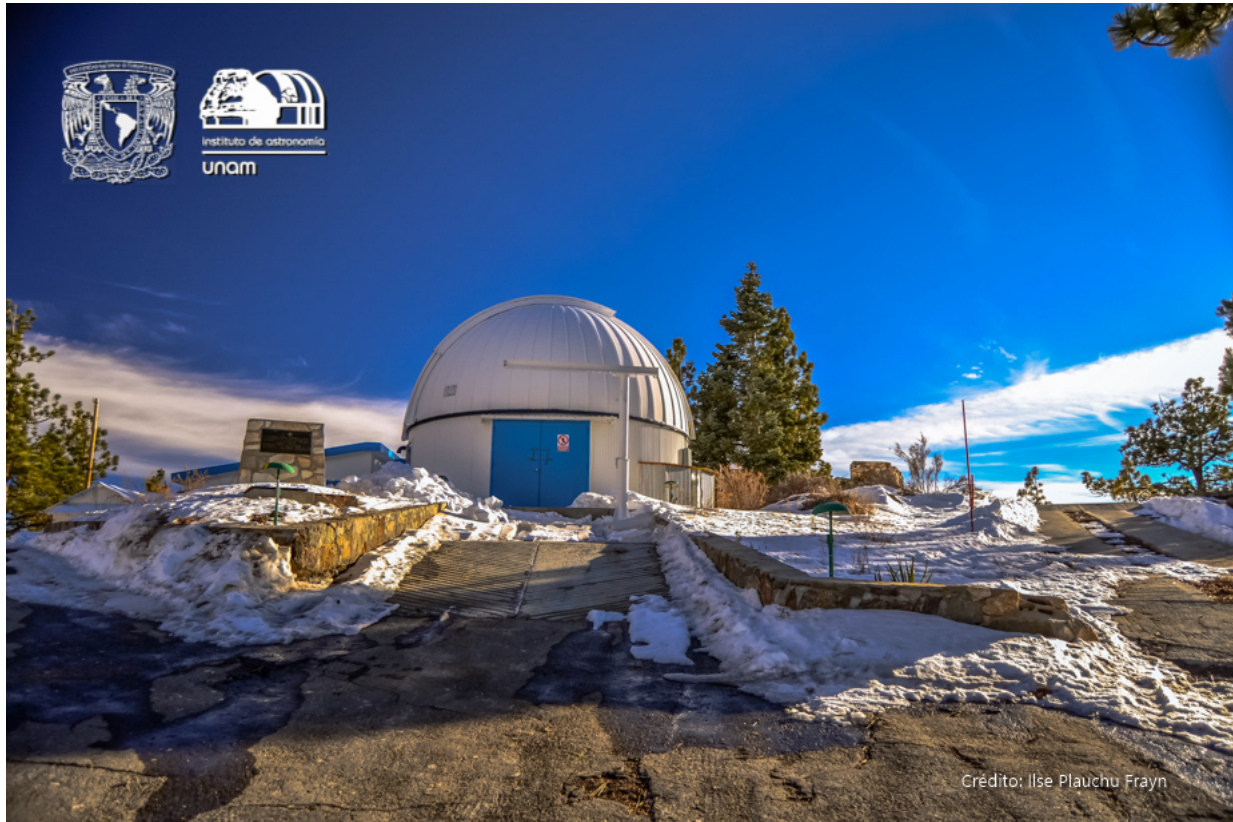
Figura 3.4: Edificio del telescopio de 1.5 m ubicado en el OAN-SPM. Imagen obtenida de: https://www.astrossp.unam.mx/es/usuarios/telescopios/tel15m .
