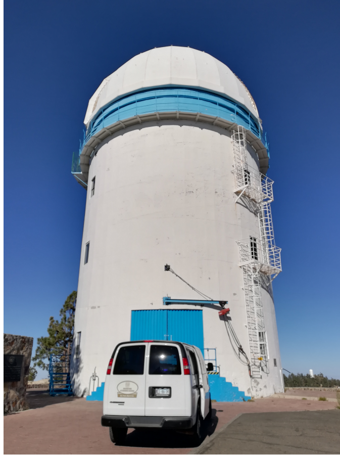
Figura 3.3: Edificio del telescopio de 2.1 m ubicado en el OAN-SPM.
