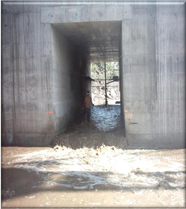
Cuando el régimen del escurrimiento es permanente, o cuando la construcción va tener un periodo de construcción mayor a 2 años o más, se debe disponer de una Obra de desvío para poder controlar el escurrimiento del río durante el tiempo que se lleve a cabo la construcción de la presa.
