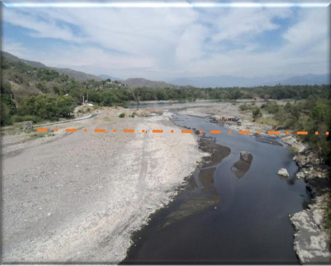
El eje de la cortina se muestra en color naranja, de acuerdo al Estudio Hidrológico se definió un periodo de retorno de  $tr = 10,000$  años, con un Gasto de diseño de  $Q = 5,842.90 \text{ m}^3/\text{s}$ , para una longitud de cortina de 150 metros, que representa una carga hidráulica de  $H = 8.07 \text{ m}$ , cabe señalar que este gasto es muy superior a lo habitual que nos fija SARH, el de utilizar para presas derivadoras un periodo de retorno de  $tr = 100$  años.
