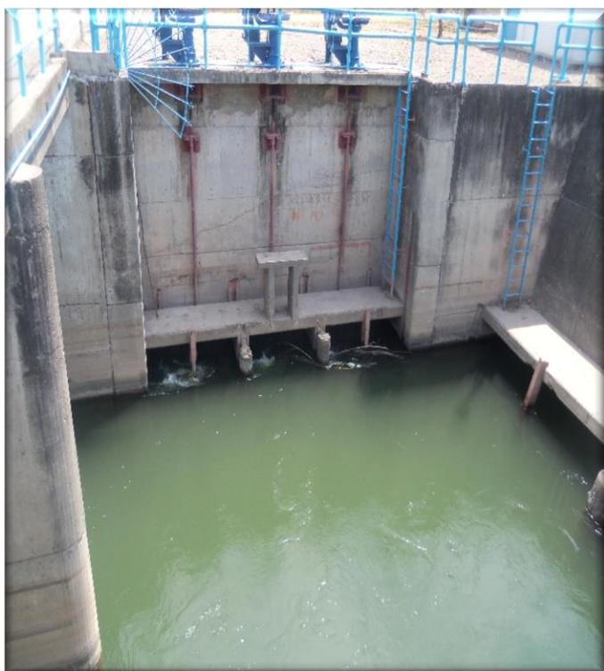
Para las dimensiones del orificio, la determinación del gasto máximo que puede pasar por las compuertas y su velocidad de salida, para el gasto de diseño, se tomó el criterio de que debían ser convencionales de hierro forjado, su velocidad de salida fue inferior a 1 m/s, evitando su achiflonamiento y el arrastre de sedimentos hacia los canales de la propia zona de riego.
