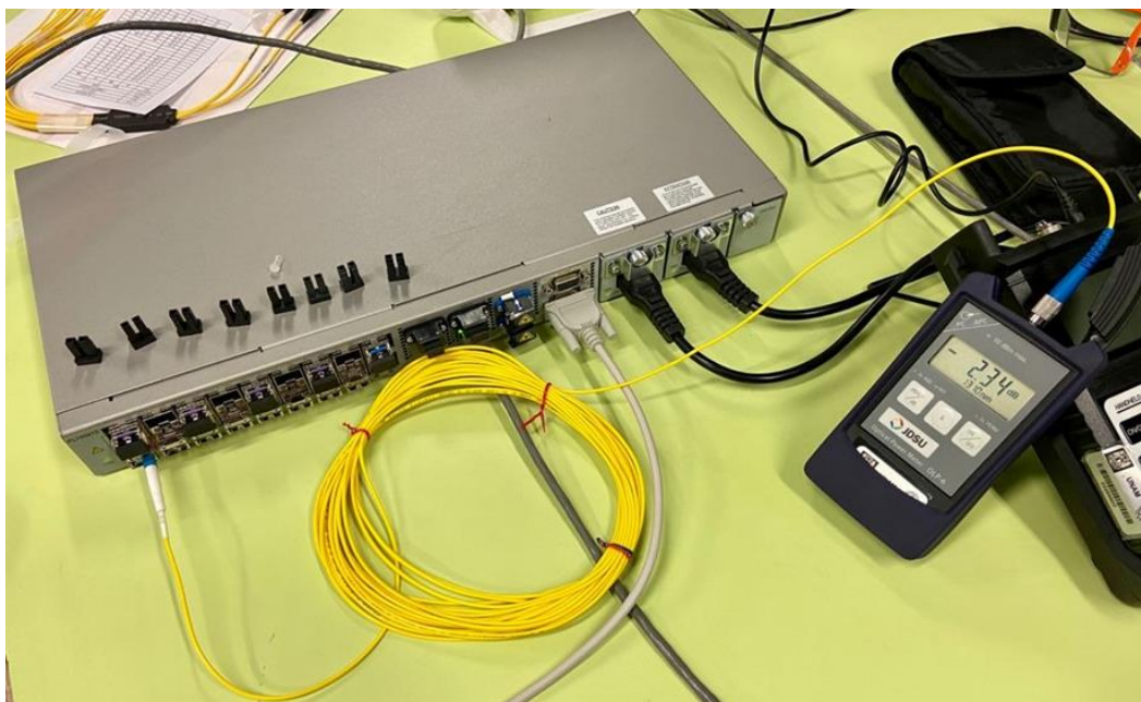
Figura 4.4 Medición de potencia óptica de los SFP+ de 1310 nm a través del Power Meter.
