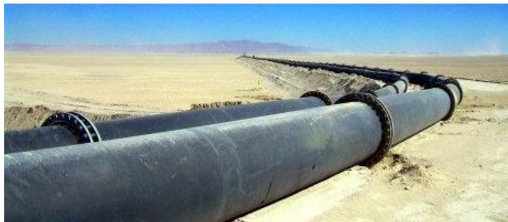
Figura 44. Conducción gravitacional de relaves y pulpas (EIC Ingenieros Consultores, 2015).
