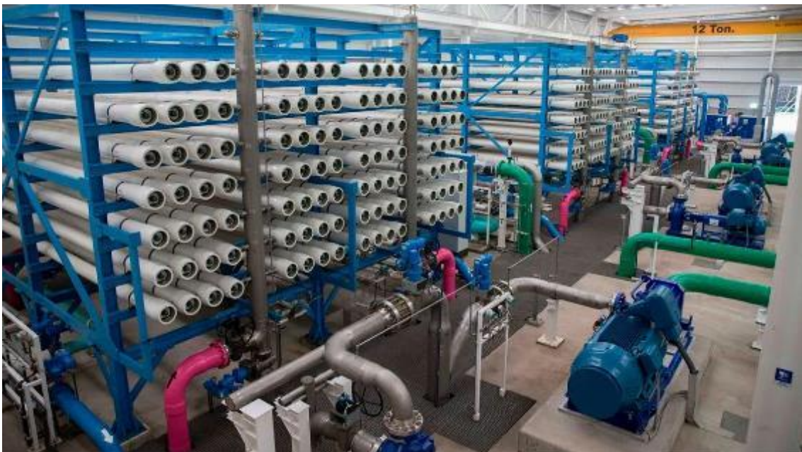
Figura 137. Equipo para ósmosis inversa en planta desaladora de Ensenada, Baja California (El Economista, 2018).
