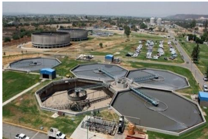
Figura 142. Espesadores por gravedad usados en el tratamiento de aguas residuales
