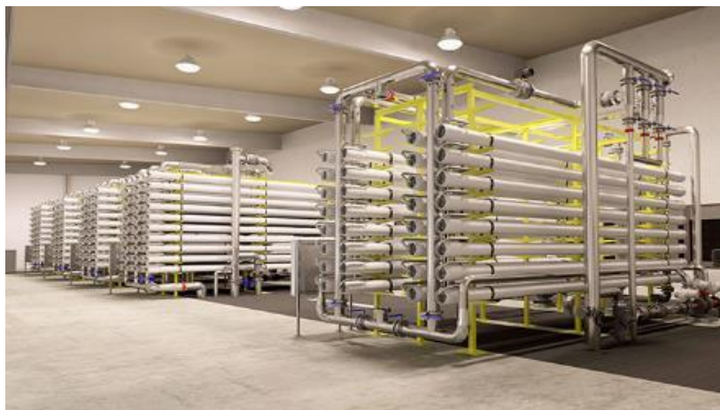
Figura 131. Equipo de ósmosis inversa
