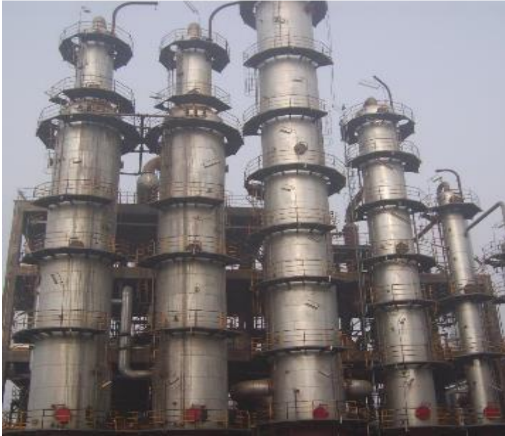
Figura 153. Columnas de fraccionamiento continuo con rectificación
