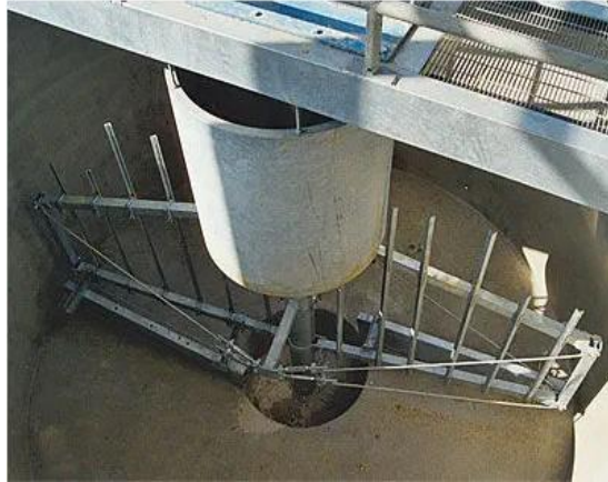
Figura 141. Rastrillos de un espesador por gravedad
