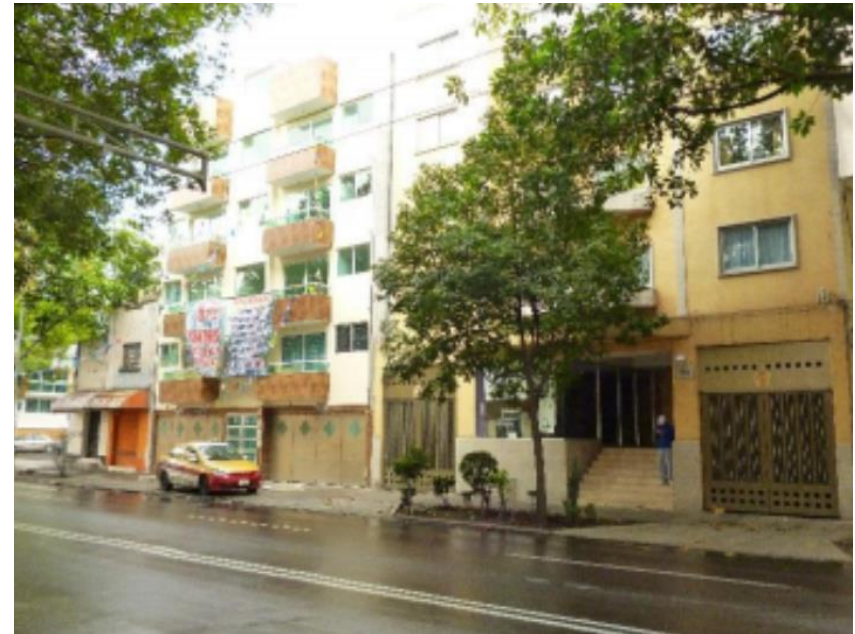
Imagen 192 Muestra edificio con más de tres niveles en la zona.
