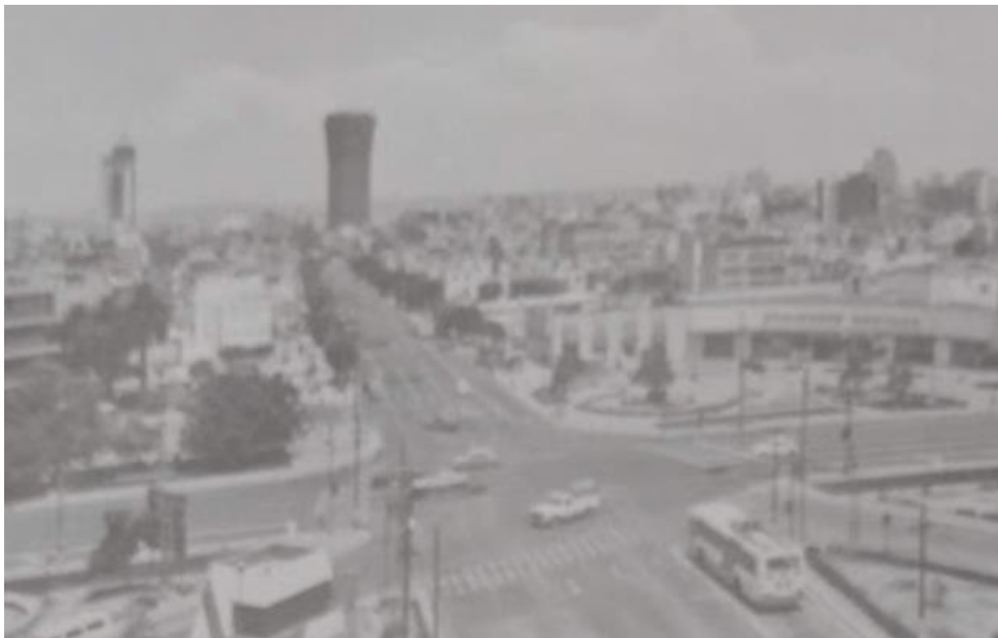
Imagen 122 Avenida Xola y Plutarco Elías Calles, posteriormente conformarían el eje 4 sur.
