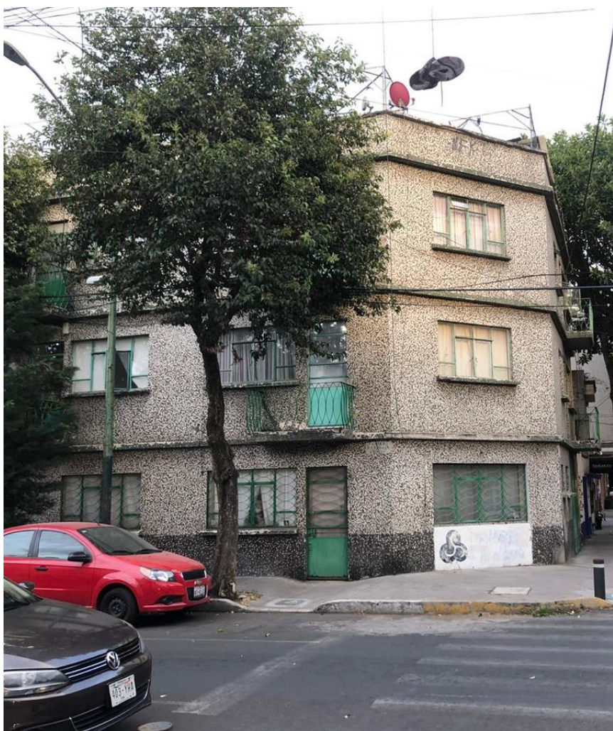
Imagen 71 Vista General del Edificio anterior ubicado en Canarias y Víctor Hugo, Col. Portales Norte
