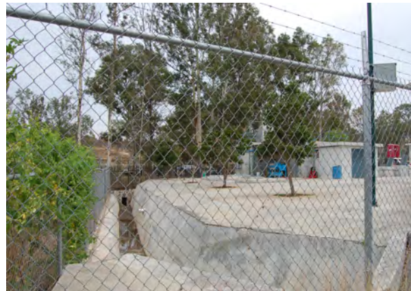
Planta de tratamiento de aguas negras
