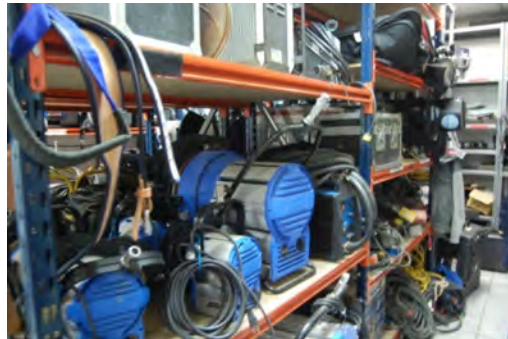
Bodega de equipo
