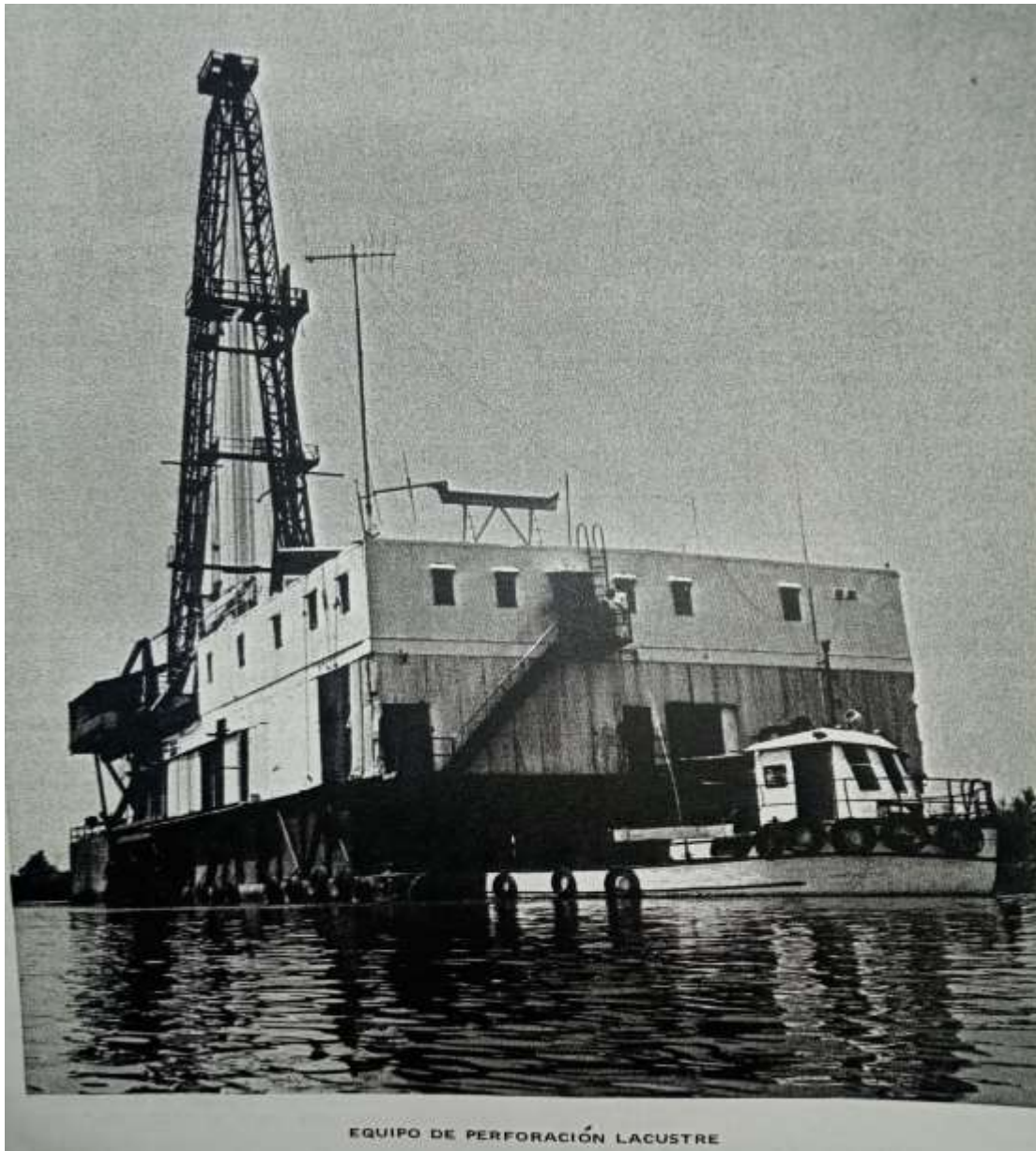
Imagen no. 4: Equipo de perforación marina 174
