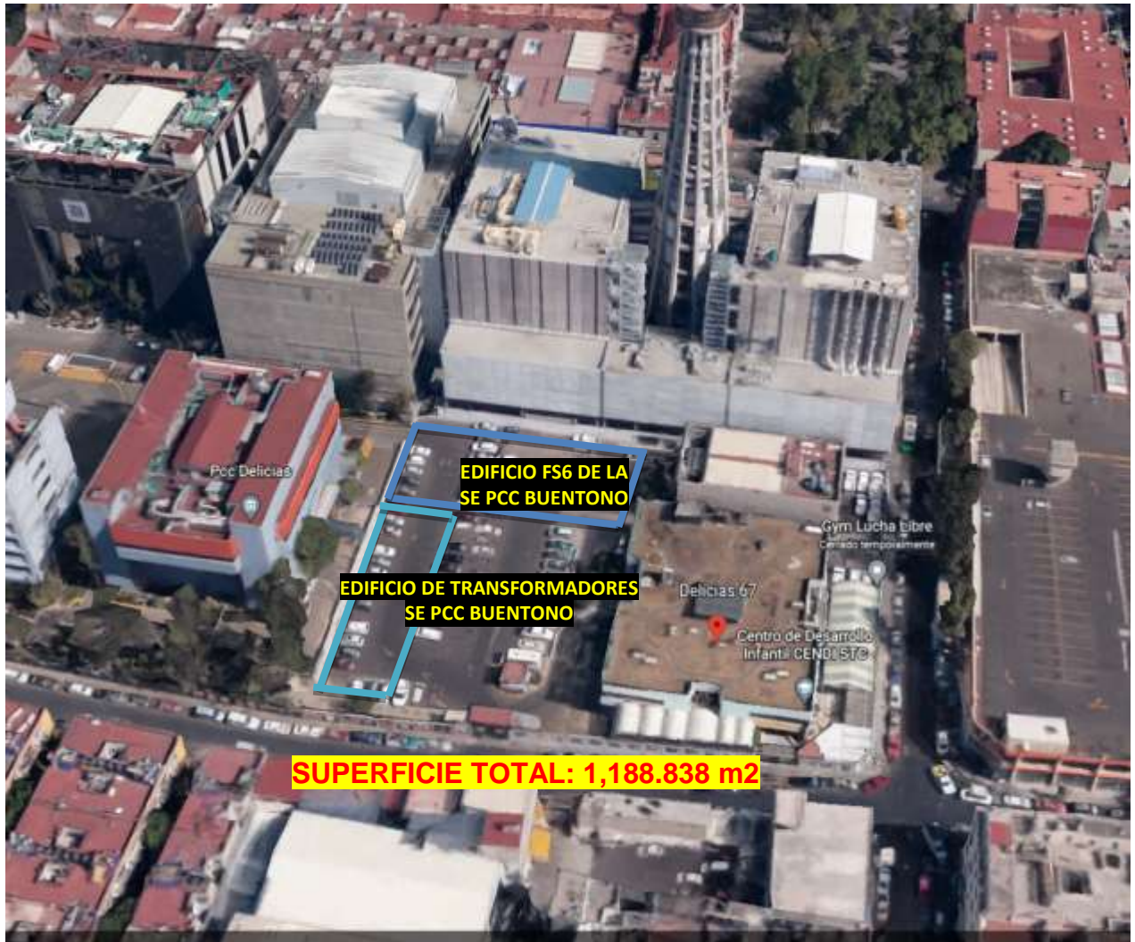
Imagen 3. Ubicación donde se construyó la S.E. PCC Buentono, que es en la calle de Delicias No. 67, colonia Centro Ciudad de México, Alcaldía Cuauhtémoc, Google Earth 2021
