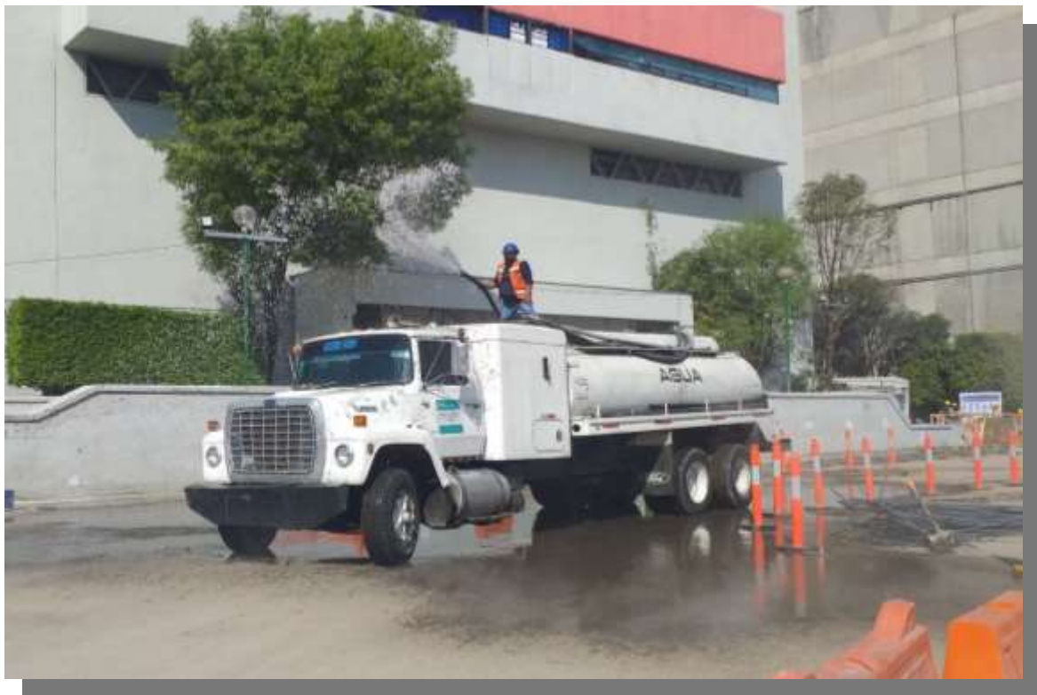
Imagen 12. En esta imagen apreciamos que se dio cumplimiento con la legislación aplicable, el uso de agua de uso tratada para el riego y evitar polvo. autoría propia, Sandra Durán Linares agosto 2022
