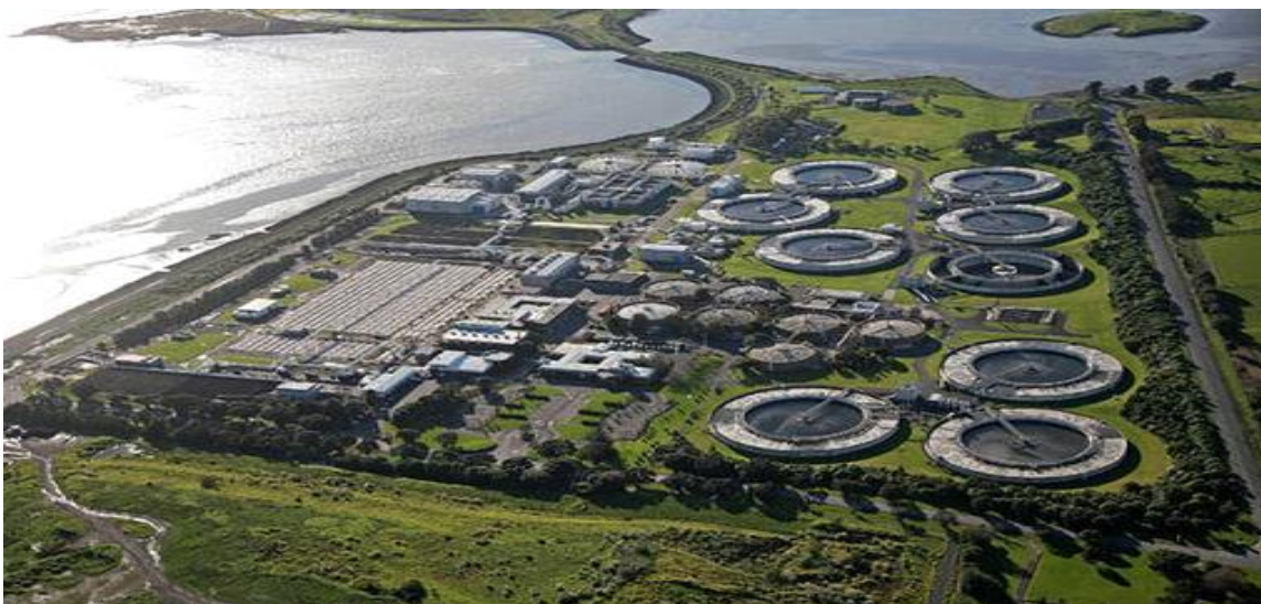
Figura 6.8 Vista aérea de la Planta Managua. Fuente 19 Digital
