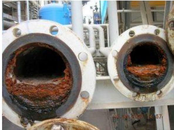
Fig. 2. Incrustaciones en un sistema de enfriamiento que reducen el flujo del agua de servicio. (Merus, 2019).
