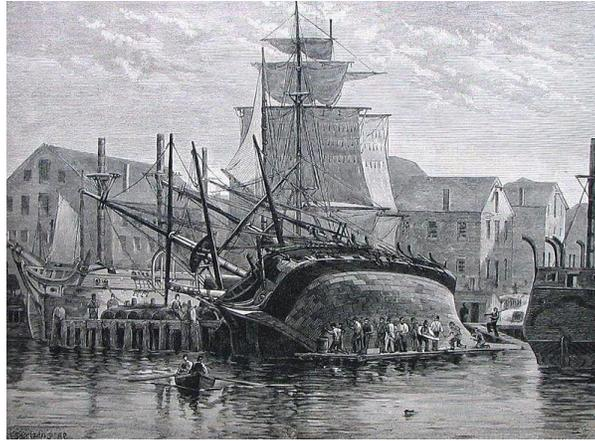
Fig. 7. Ilustración que muestra un ejemplo de carenado de un barco de madera en un astillero (Atlántico, 2020).
