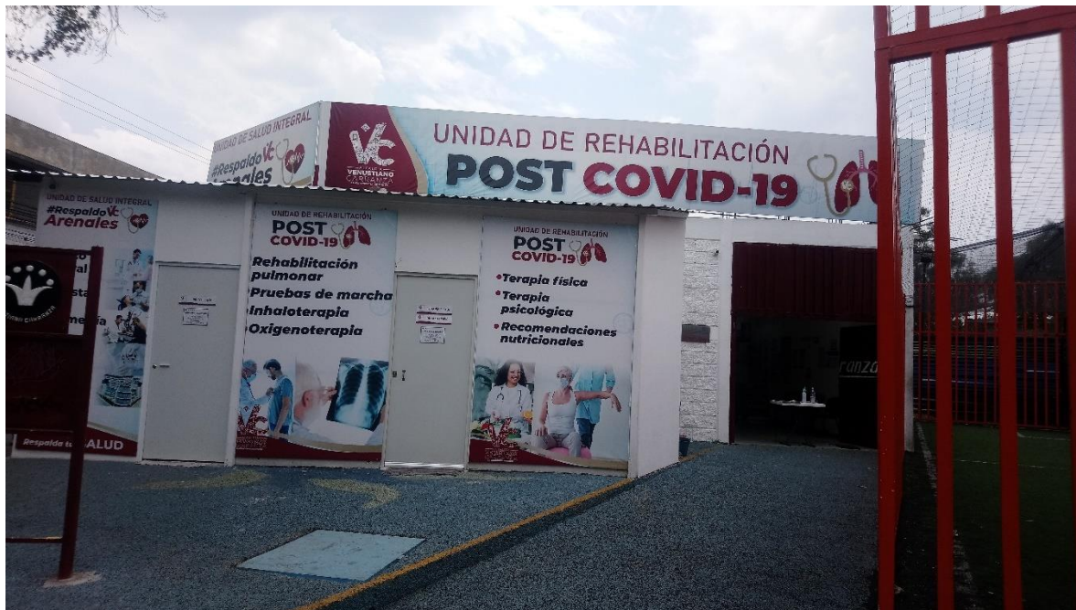
Fig. 6: Foto actual de ahora extinto salón comunitario en su origen fue construido por los habitantes de Guendaliza’a por medio del programa de Mejoramiento Barrial, el salón que de acuerdo con los vecinos les fue despojado por la Alcaldía que lo transformó después en una clínica, (fuente propia).
