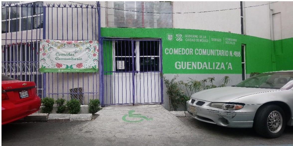
Fig. 13: Vista externa del Comedor Comunitario Guendaliza'a (fuente propia).
