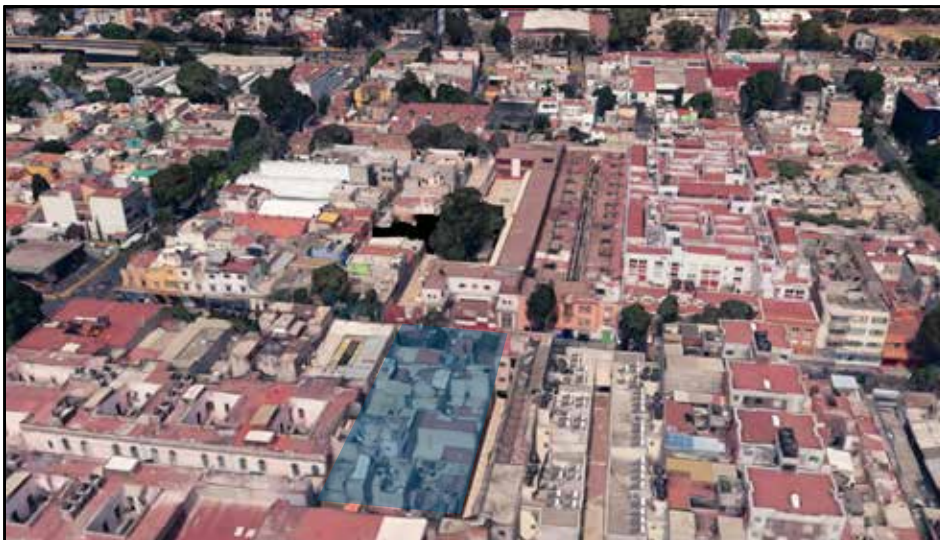
[Fig. 25]. Vista Oriente
