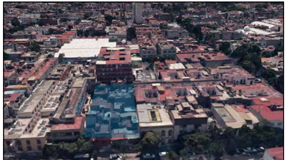
[Fig. 26]. Vista Poniente
