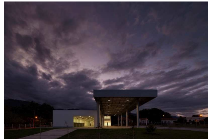
IMAGEN 2.62 Fachada principal de noche.
