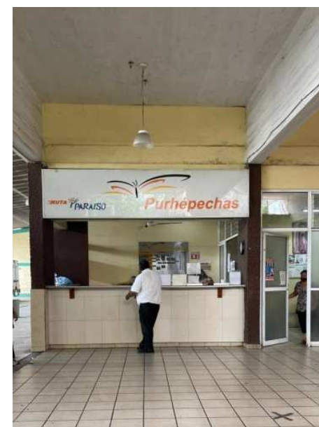
IMÁGENES 1.19, Área de taquillas, actuales instalaciones de la estación Purépechas en Apatzingán, Mich.
