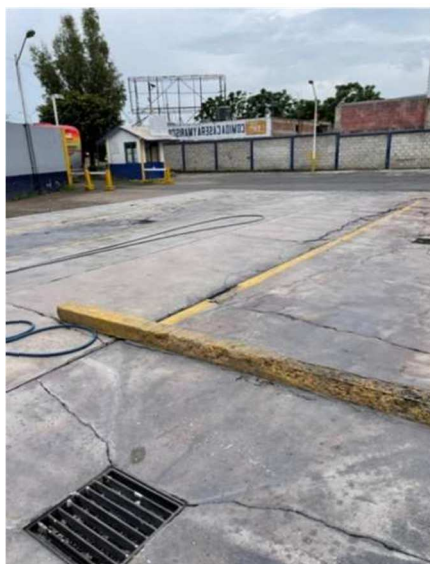
IMAGEN 2.15 Tiene carriles muertos en los que colocan los autobuses que ocupan alguna reparación o cuando los lavan.
