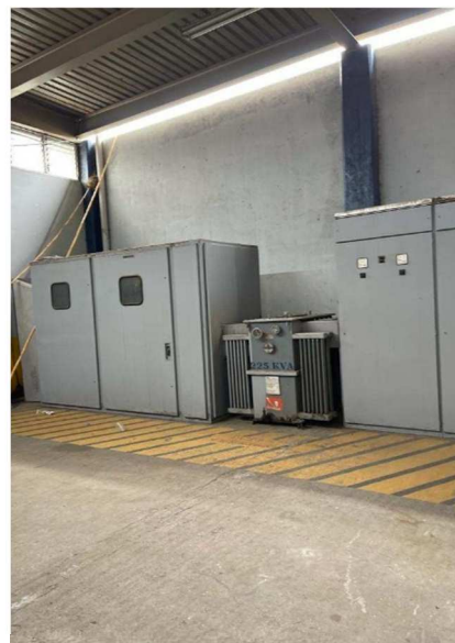
IMAGEN 2.18, IMAGEN 2.19 tiene dos cuartos de máquinas, para las instalaciones hidráulicas incluyendo la cisterna, y el otro es cuarto eléctrico, en el cual se cuenta con una subestación.
