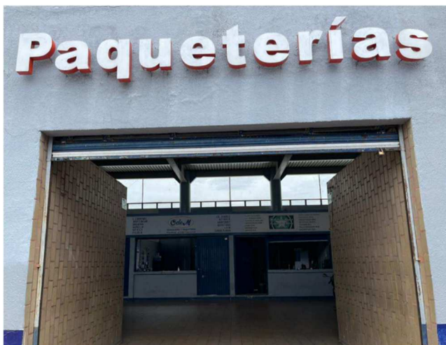
IMAGEN 2.9 Cuenta con servicio de paquetería. En el interior se tiene un gran vestíbulo, bien iluminado y ventilado. Cada módulo cuenta con una recepción, bodega y área de carga/descarga.
