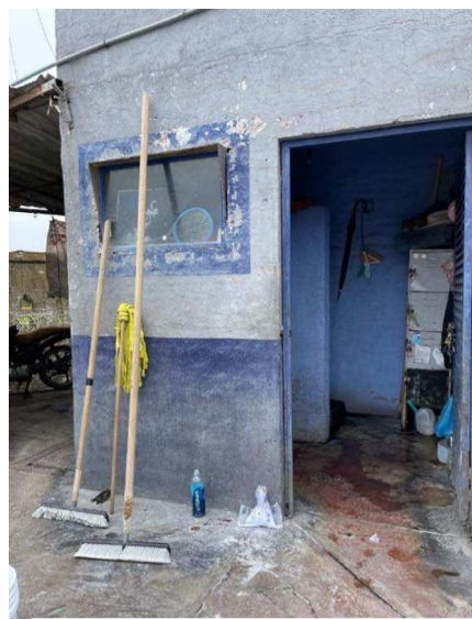
IMAGEN 2.16 Cuenta con un almacén para el equipo necesario del lavado de autobuses. Y un baño.
