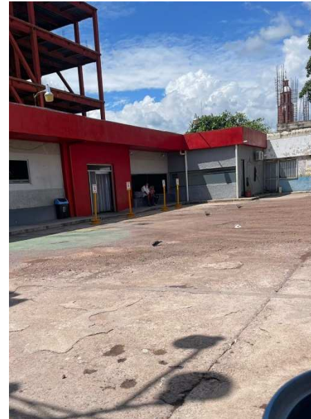
IMÁGENES 1.14 anden y carriles, actuales instalaciones de la estación Parhikuni en Apatzingán.
