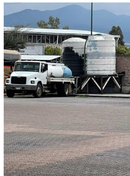
IMAGEN 2.46, 2.47 Cuenta con un lavado, el cual es utilizado por todas las líneas, para abastecer el agua de esta área cuentan con dos enormes tinacos que son llenados con pipas de agua.
